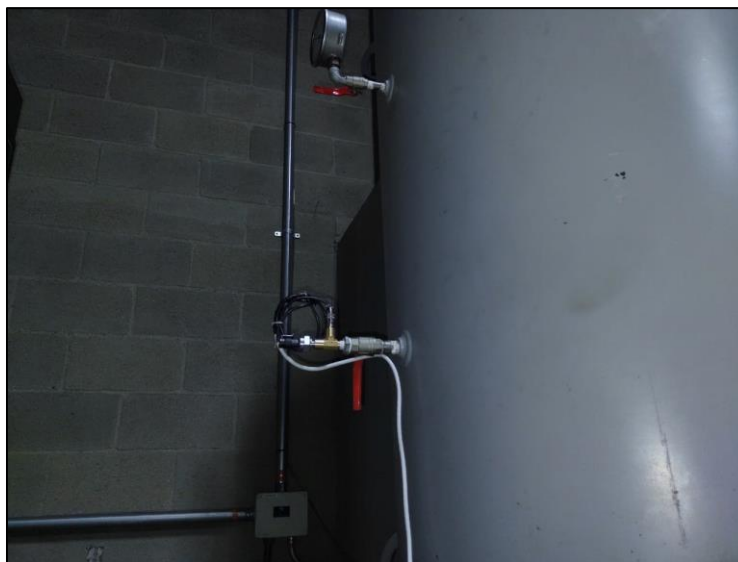
Figura 29. Instalación sensor de humedad.
