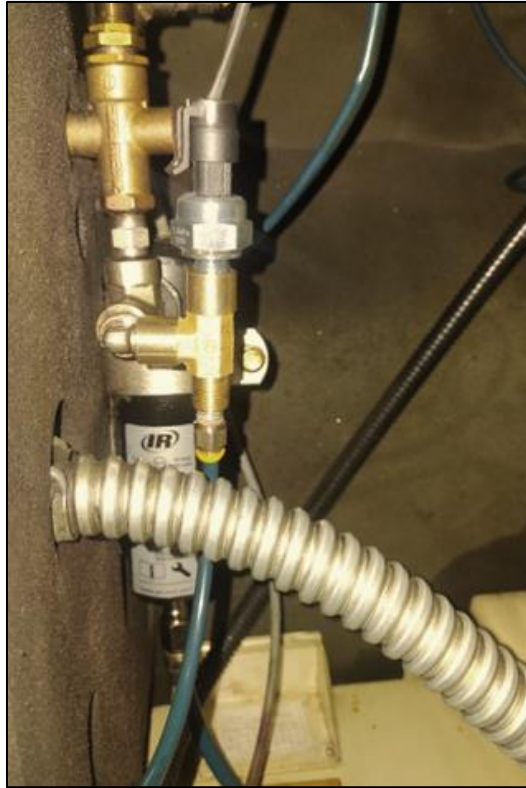
Figura 28. Instalación sensor de presión en compresor secundario.
