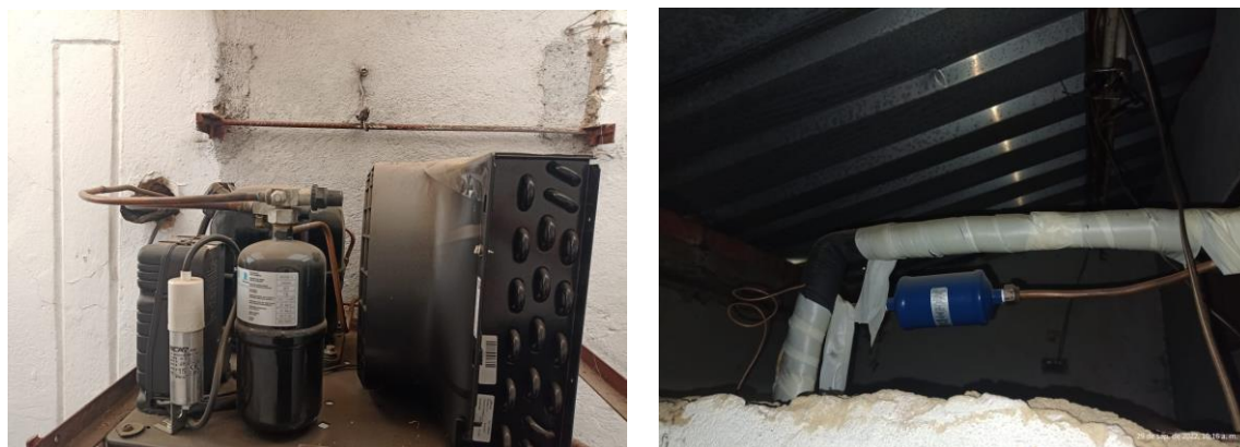
Ilustración 9. Revisión de conexiones de tubería.
