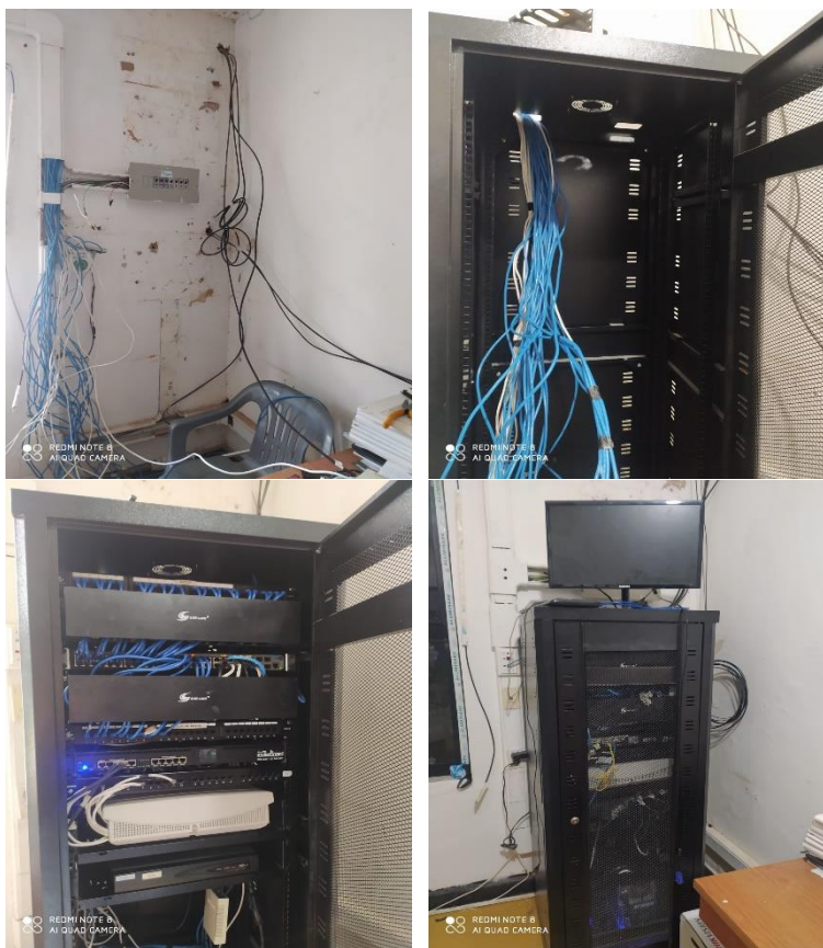
Figura 13. Instalación de RACK
