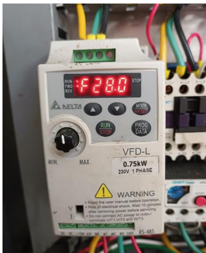
Figura 6-58. Frecuencia ideal del variador
