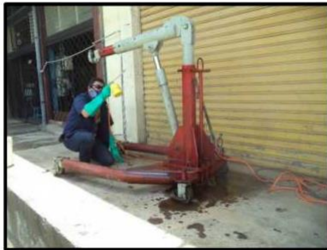
Figura 14. Lavado e inspección de los componentes (grúa pluma). [21]
