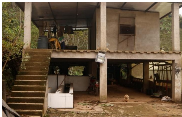
Instalaciones de despulpe, lavado y secado del café
