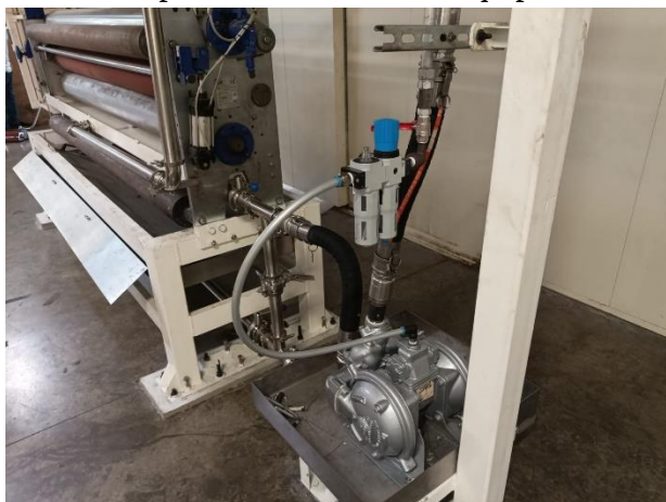
Figura 54. Instalación de tubería en retorno de adhesivo con conexión neumática a equipo auxiliar 1. Fuente: Autor.
