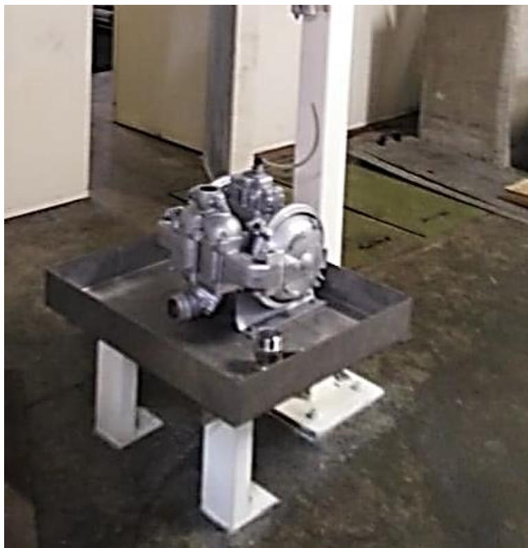
Figura 60. Instalación de bandeja de aguas residuales a equipo auxiliar 1. Fuente: Autor.
