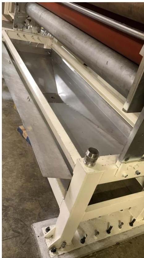
Figura 59. Instalación bandeja de aguas residuales a equipo ACP-850. Fuente: Autor.
