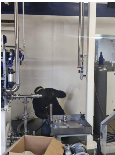
Figura 51. Instalación de tubería de alimentación en equipo ACP-850. Fuente: Autor.
