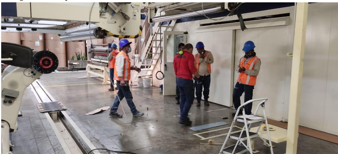
Figura 40. Empresa contratista M&M realizando planeación de instalación. Fuente: Autor.
