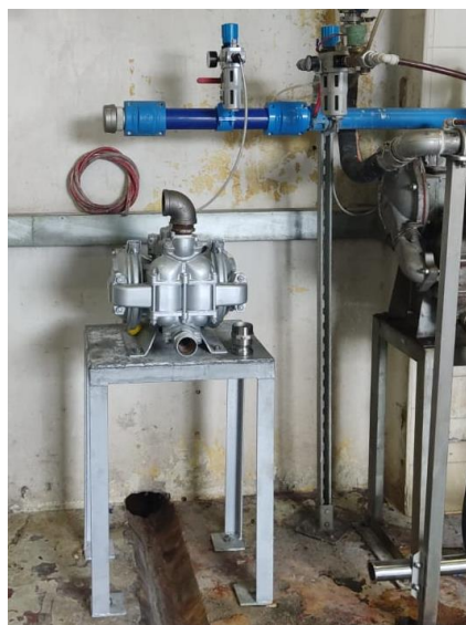
Figura 48. Instalación equipo auxiliar 2. Fuente: Autor.
