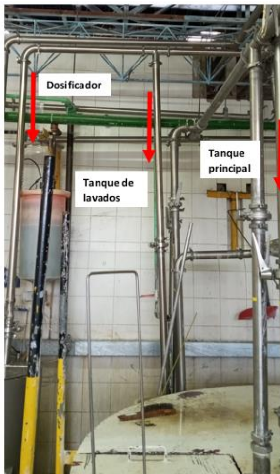
Figura 57. Instalación tubería retorno a tanque principal, tanque de lavado y dosificador. Fuente: Autor.
