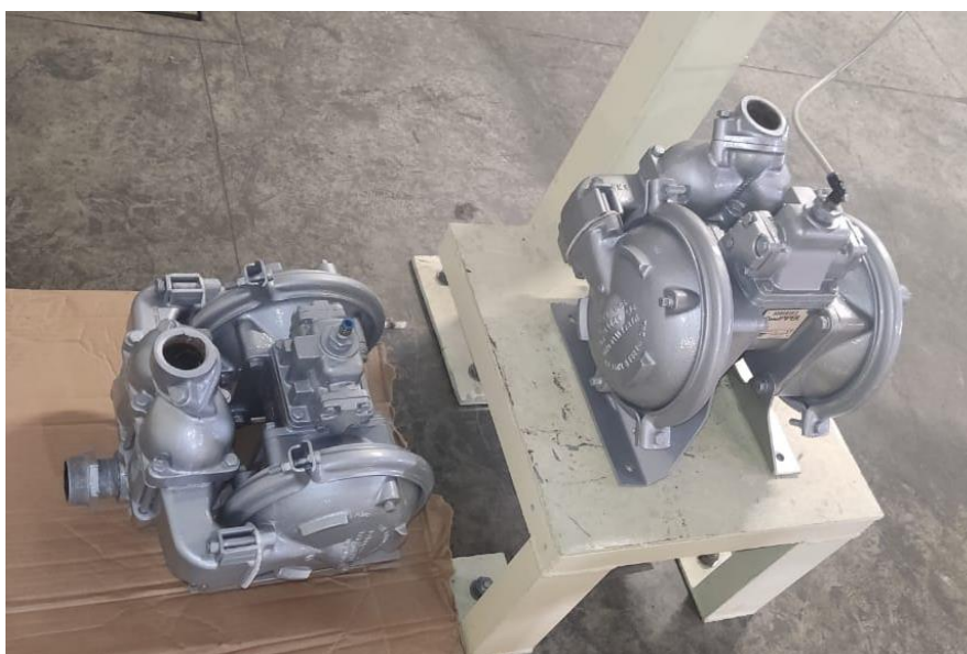
Figura 44. Equipo auxiliar 1 y 2 (bombas sandpiper) después de realizar mantenimiento. Fuente: Autor.
