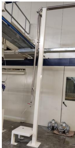
Figura 45. Instalación de soporte a equipo auxiliar 1. Fuente: Autor.
