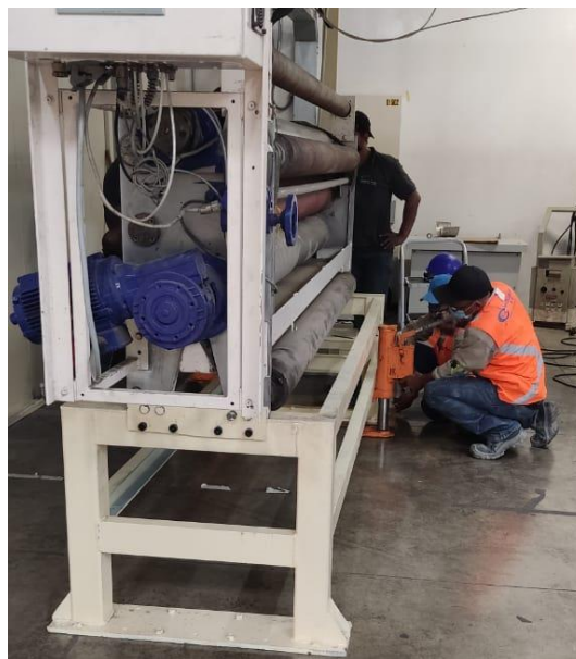
Figura 41. Empresa contratista M&M realizando instalación. Fuente: Autor
