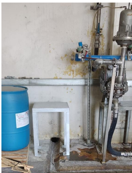
Figura 46. Instalación de soporte a equipo auxiliar 2. Fuente: Autor.
