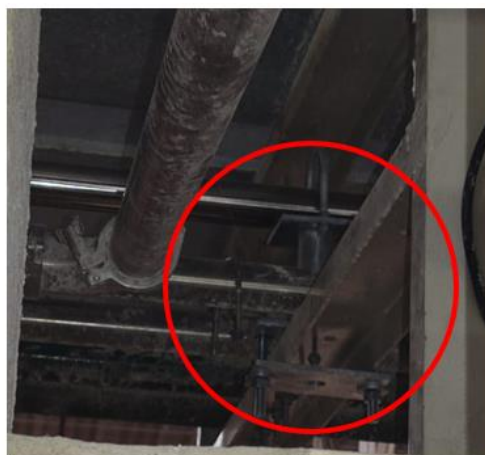
Figura 50. Instalación de soportes en rack de servicio módulo 11. Fuente: Autor.
