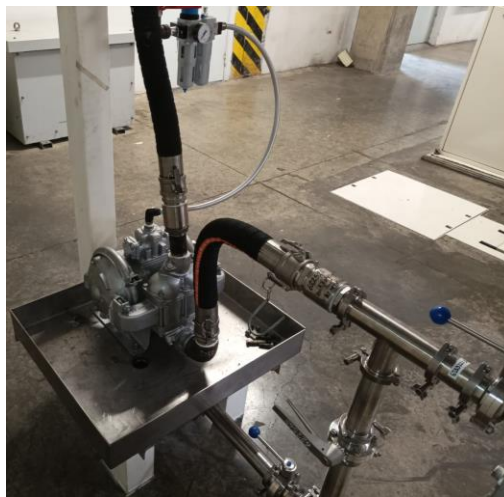
Figura 47. Instalación equipo auxiliar 1. Fuente: Autor.
