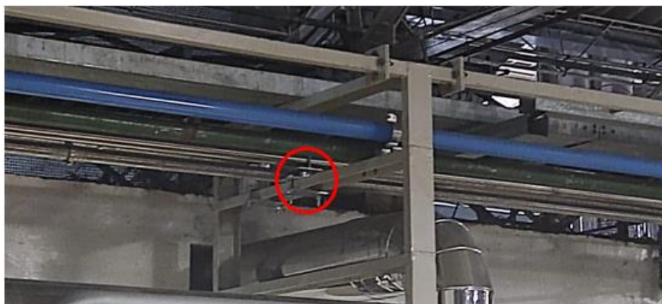
Figura 49. Instalación de soportes para tubería en rack de servicio módulo 8. Fuente: Autor.
