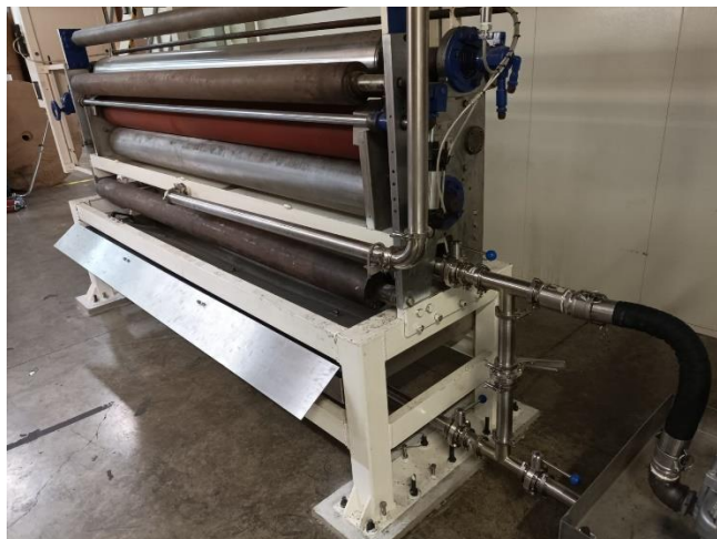
Figura 53. Instalación completada de tubería en equipo dual arch. Fuente: Autor.
