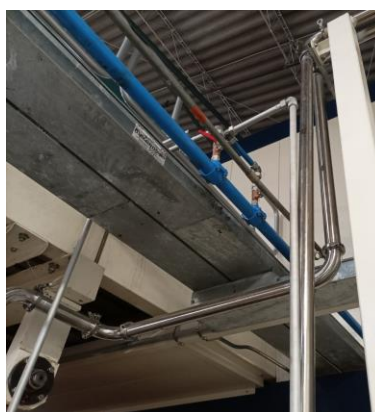
Figura 52. Instalación de tubería bajando del rack principal. Fuente: Autor.
