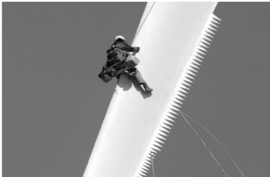
Figura 7: Escalador quitando las protuberancias "trips" de la hoja dentada. Fuente: (Oerlemans et al., 2009)
