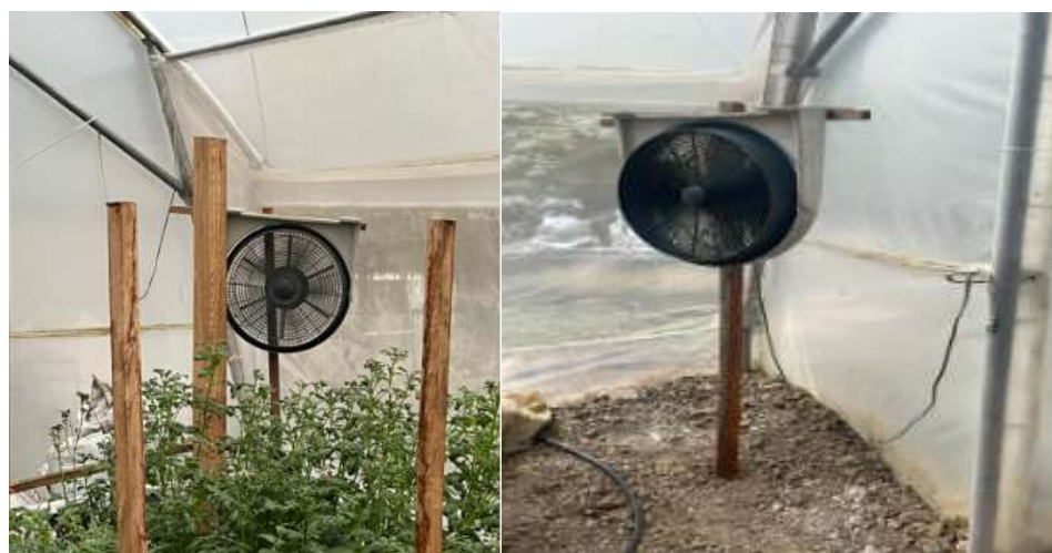
Figura 12. Ventiladores de bajo caudal en soporte de madera.
