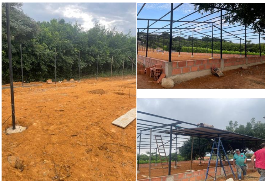
Imagen 16 Acompañamiento en la construcción de galpones Granja San Francisco
