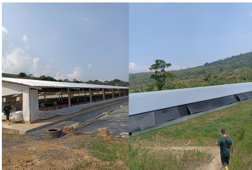
Figura 12. Instalaciones de la zona de producción y de levante
