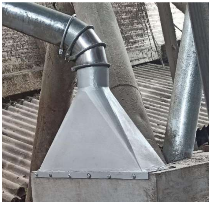
Figura 73 Campana instalada
