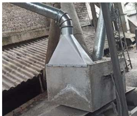
Figura 80 Instalación de puntos de succión
