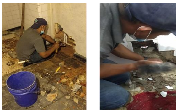
Figura 25: Mantenimiento y reparación de la tubería de agua potable del Salón Colombia
