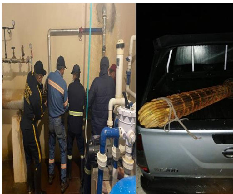
Figura 37: Retiro de serpentín para su reconstrucción
