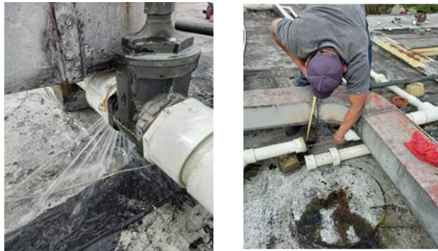
Figura 27: Reparación de la tubería por pérdidas de agua potable en la terraza
