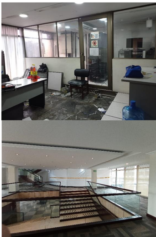
Figura 21: Acompañamiento a la remodelación de instalaciones físicas de Data Center de respaldo
