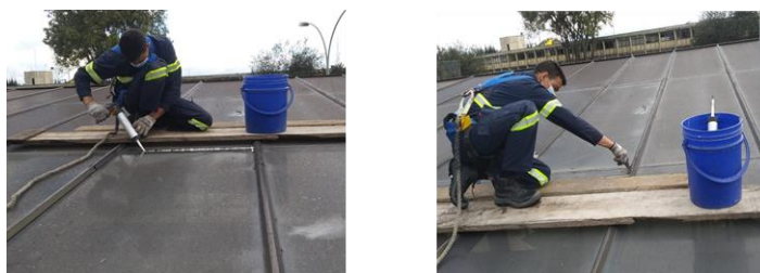
Figura 24: Mantenimiento e impermeabilización de la estructura en vidrio del Salón Colombia
