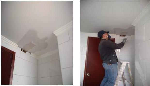
Figura 31: Mantenimiento y recuperación del baño Swit 301
