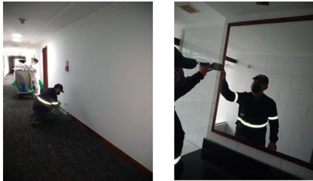
Figura 32: Reparación daños del pasillo del cuarto piso
