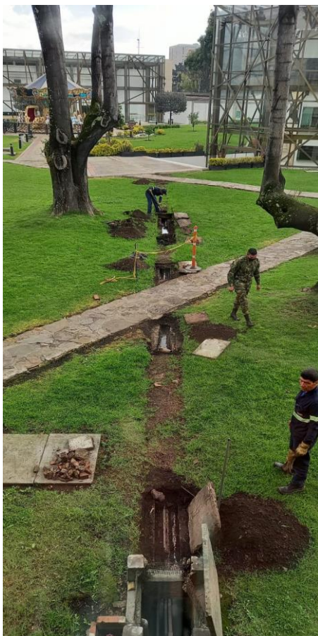
Figura 39: Mantenimiento de Redes Hidráulicas sede Principal
