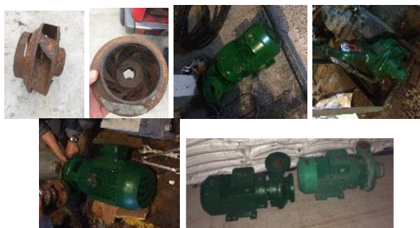
Figura 16: Mantenimiento correctivo a las bombas de la caldera de piscinas de adultos
