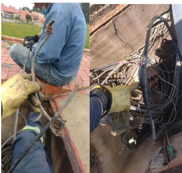
Figura 36: Mantenimiento y reparación Aislamiento del neutro en el sistema eléctrico de las cabañas
