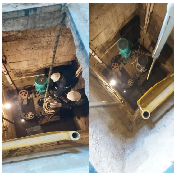
Figura 33: Desmonte de bomba principal de bocatoma para mantenimiento
