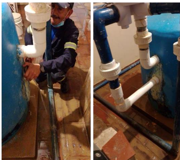
Figura 34: Mantenimiento fuga en tubería de PVC de agua
