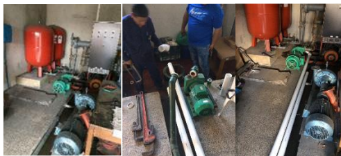
Figura 15: Instalación de conexión de bypass del tanque auxiliar con el sistema de bombeo general
