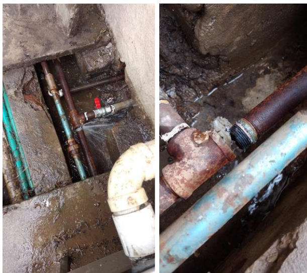
Figura 35: Mantenimiento tubería de vapor ceptor cafetería de socios
