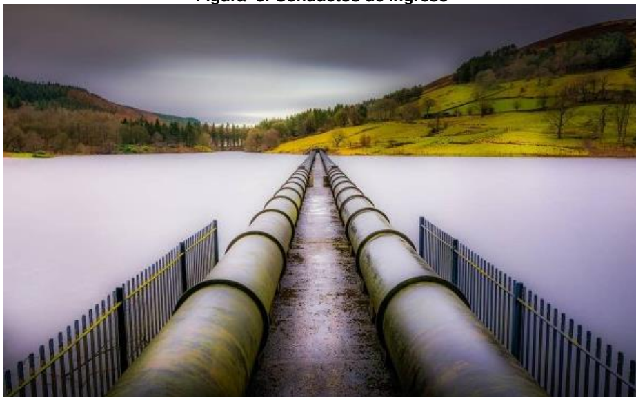
Figura 5. Conductos de ingreso
