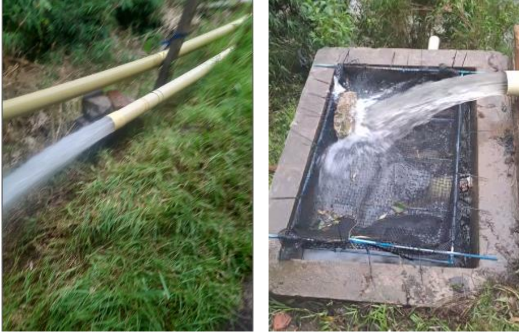
Figura 25 a. Montaje de tubería b. Rejilla de retención de suciedades.
