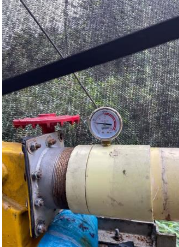
Figura 28 Manómetro análogo instalado antes de la entrada de la turbina.
