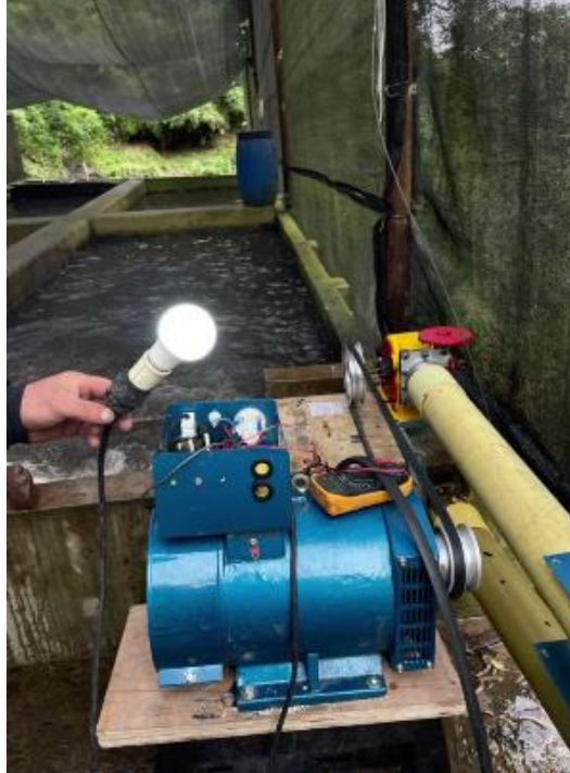
Figura 34 Montaje picocentral hidroeléctrica "La Cascada".
