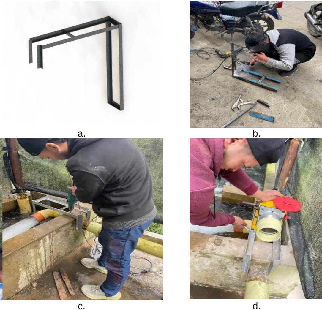
Figura 26. a. Diseño de la base b. Fabricación de la base c. Montaje de la base d. Montaje de la turbina.
