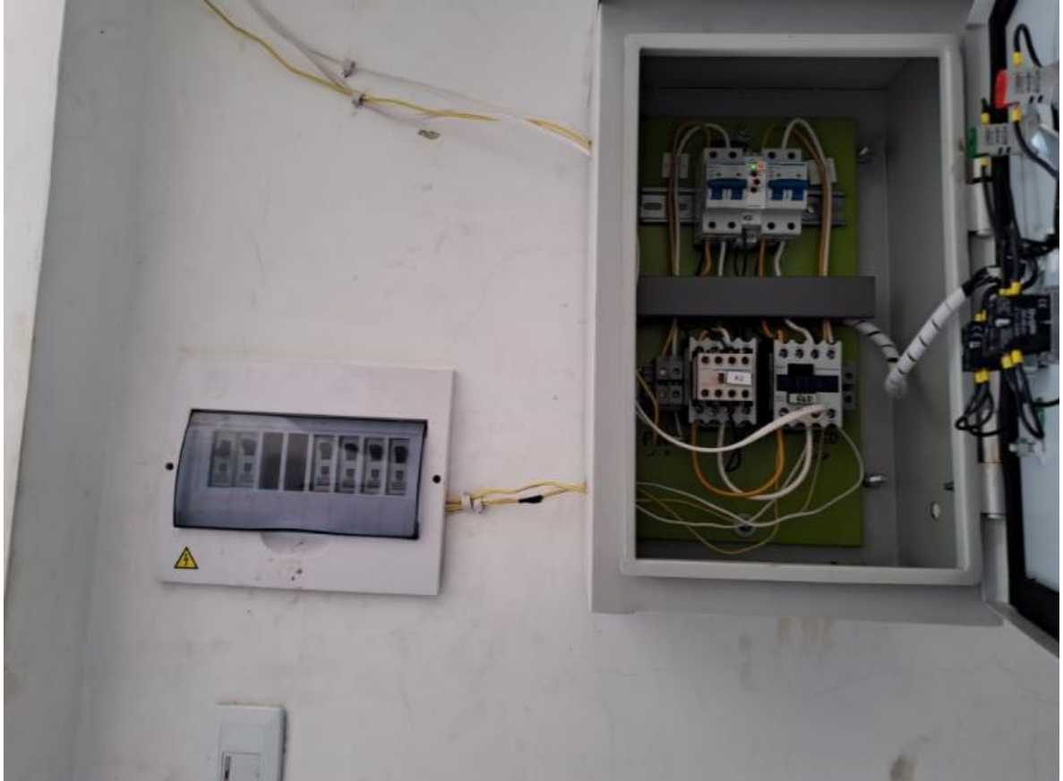
Figura 32. Montaje del sistema de control.
