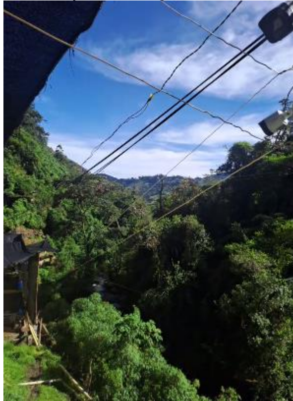
Figura 33. Montaje de la red del generador a la transferencia.
