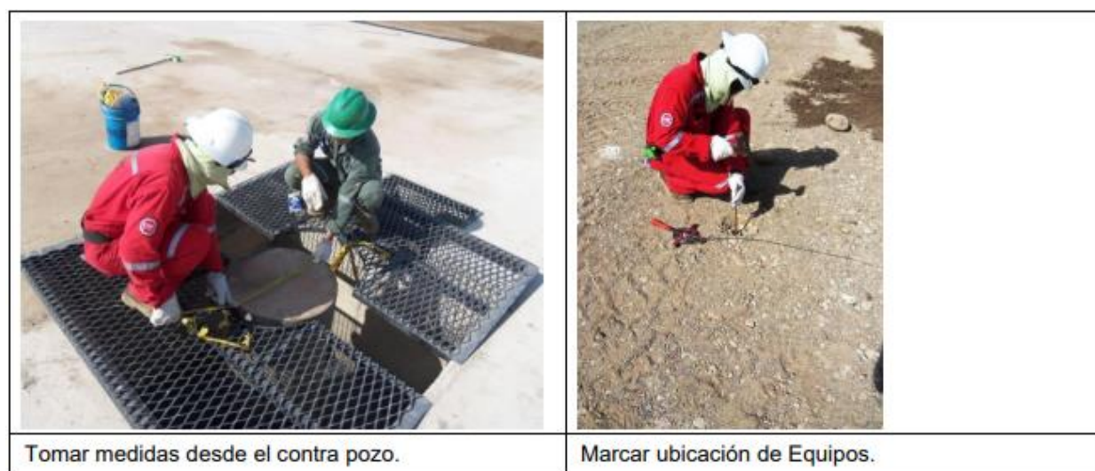
Imagen 2. Toma de medidas y marcación de ubicación de equipos.
