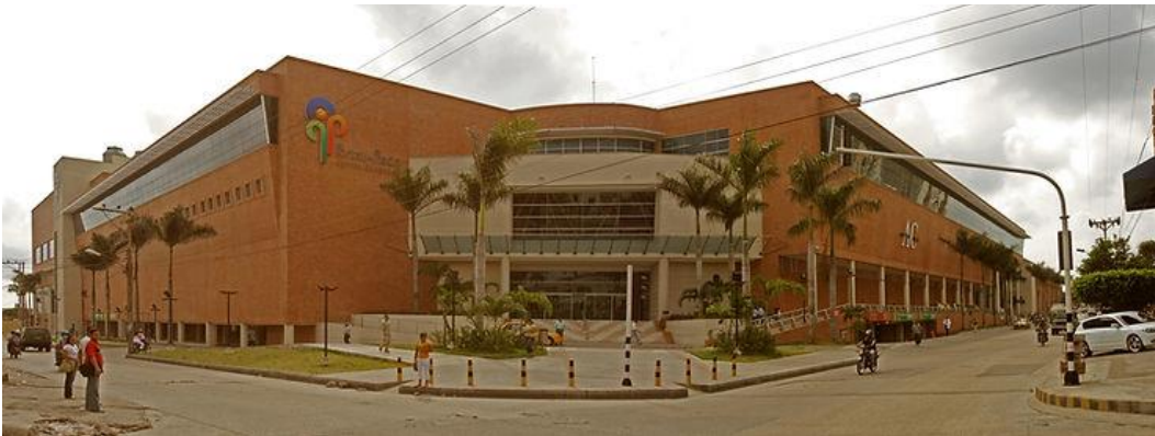
Ilustración 9 Estado actual del parqueadero
