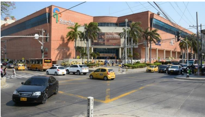
Ilustración 11 Estado actual del parqueadero
