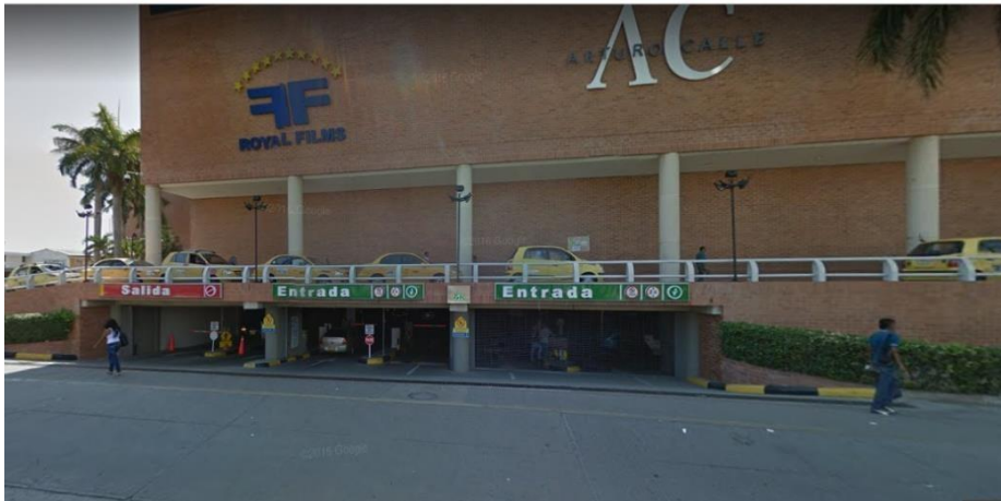
Ilustración 6 Acceso y Salida Zona de Parquaderos
