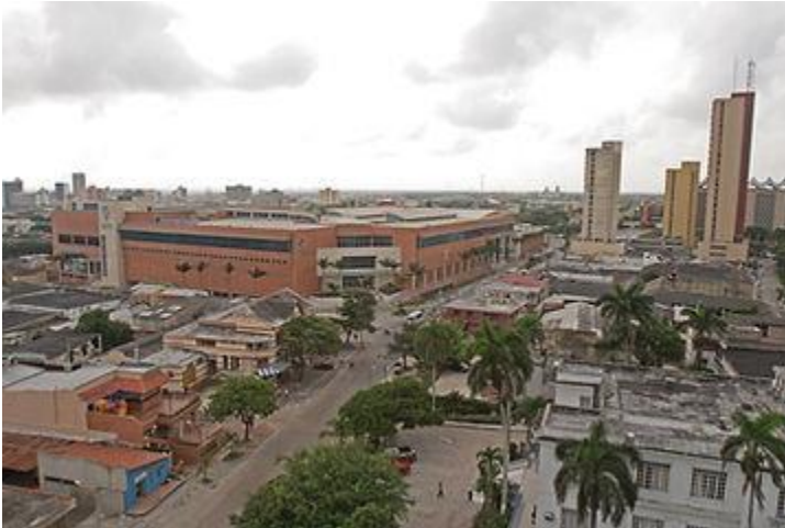
Ilustración 10 Estado actual del parqueadero
