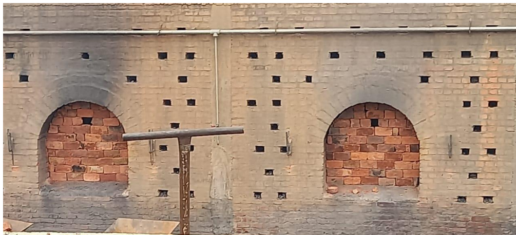
Figura 3. Puertas de hornos selladas con ladrillo. Autor (2022)
