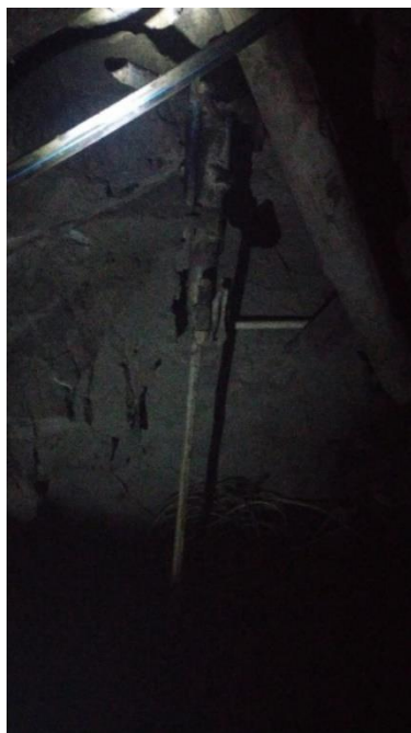
Ilustración 16 Perforadora-Fuente: mina Norway
