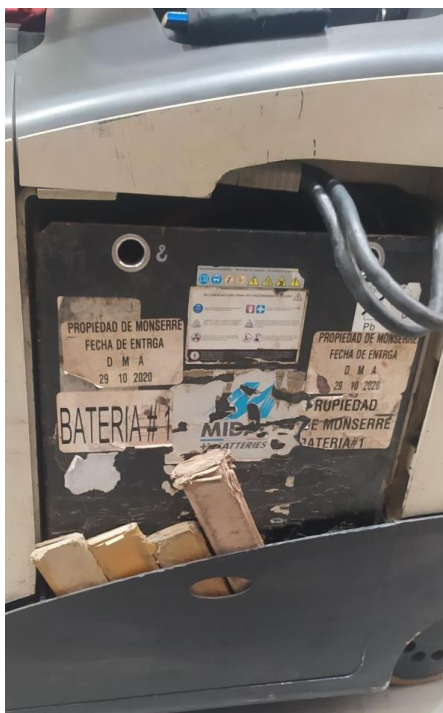
Ilustración 30 - Estado de batería
