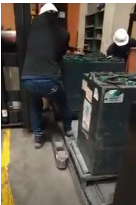
Ilustración 18 - Halar batería
