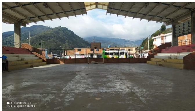
Ilustración 40 Imagen Coliseo Cubierto
