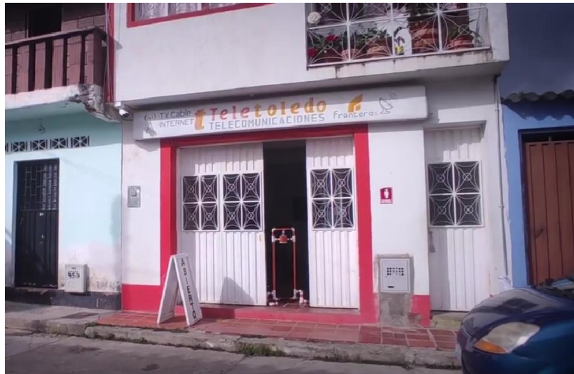
Ilustración 8 entrada de la oficina Teletoledo
