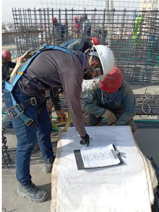
Ilustración 8. verificación de planos de detalles de aceros para elementos estructurales por parte del aprendiz
