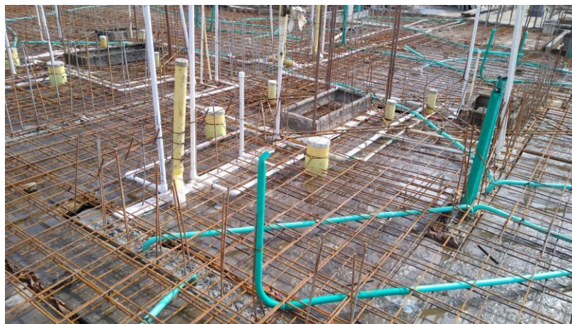
Ilustración 26. Aceros de refuerzo en placa de entepiso
