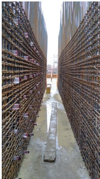
Ilustración 22. aceros de refuerzo en muros de pasillo
