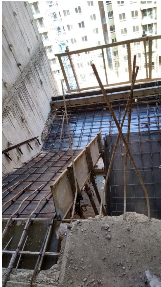
Ilustración 27. detalles de escalera Torre 8
