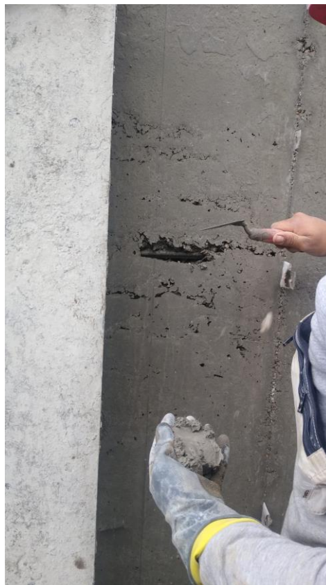
Ilustración 31. reparación superficial de elemento estructural
