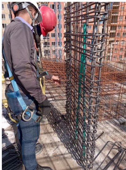
Ilustración 21. revisión de aceros de refuerzo en muros
