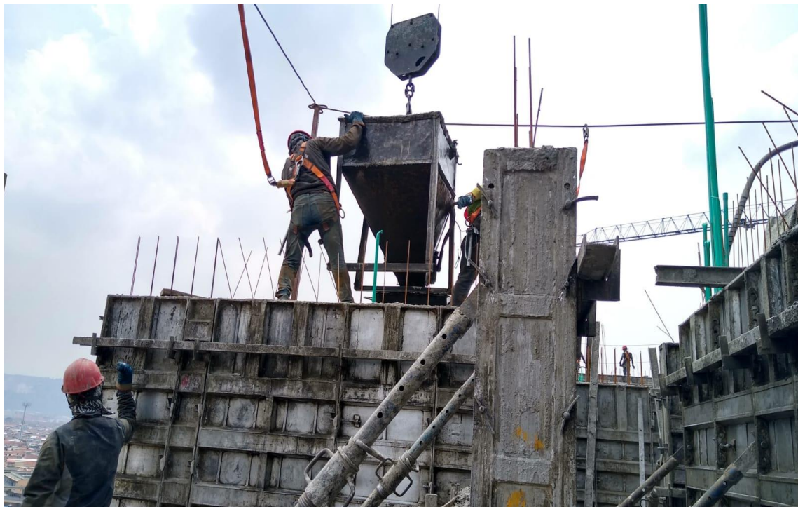
Ilustración 28. vaciado y vibrado de concreto en muros Torre 8
