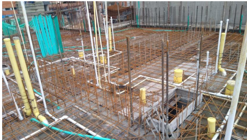
Ilustración 25. Aceros de refuerzo en placa de entepiso Torre 8
