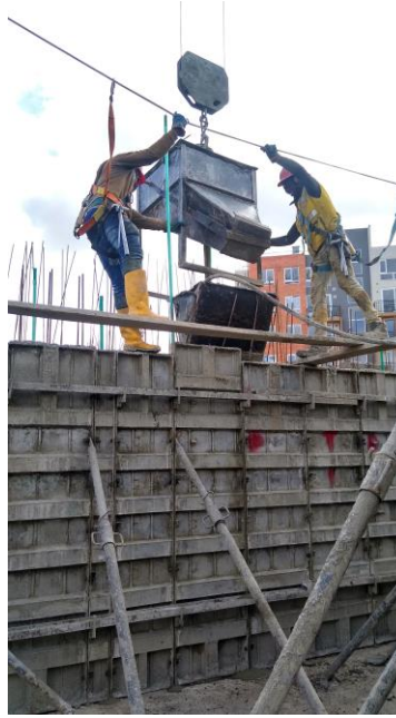
Ilustración 29. vaciado y vibrado de concreto en muros
