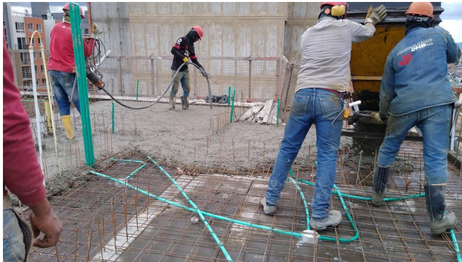
Ilustración 30. Vaciado y vibrado de concreto en placa de Torre 8
