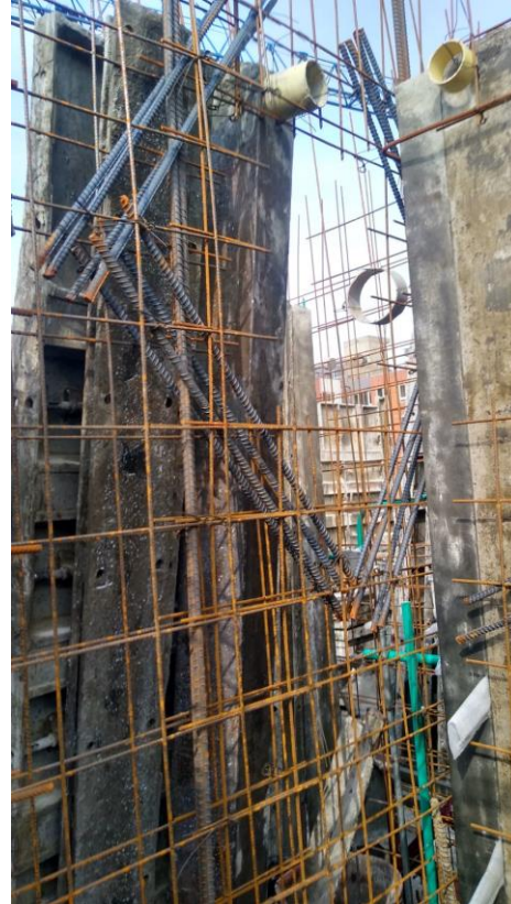
Ilustración 23. refuerzo de acero en vano de muro
