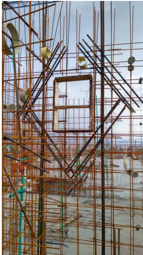
Ilustración 24. refuerzo de acero en vano
