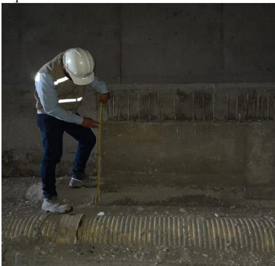
Ilustración 13 Revisión de dimensionamientos en arquetas
