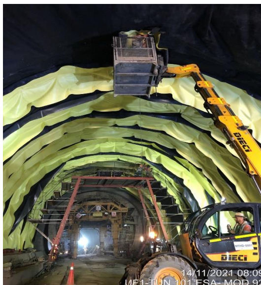
Ilustración 10 Instalación Geo membrana en PVC clave en bóveda
