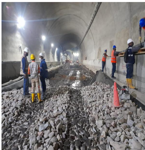
Ilustración 25 Tendido de piedra gavión filtro en canal francés
