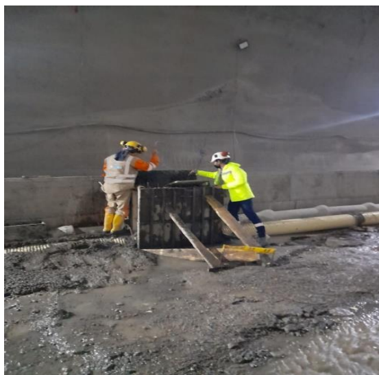
Ilustración 20 Inspeccion de fundida de arquetas en concretos
