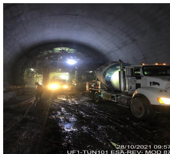
Ilustración 22 Fundida de carro de avance concretos provenientes CEMEX.
