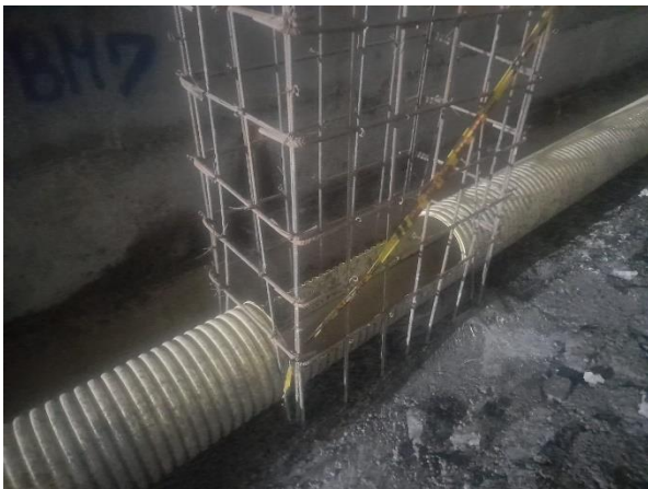
Ilustración 17 Figurado de hierro en arquetas agua de infiltración
