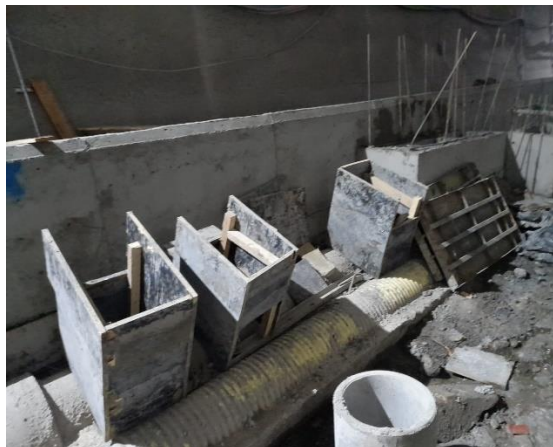
Ilustración 18 Formaletas para fundición de arquetas para derrame de aceites
