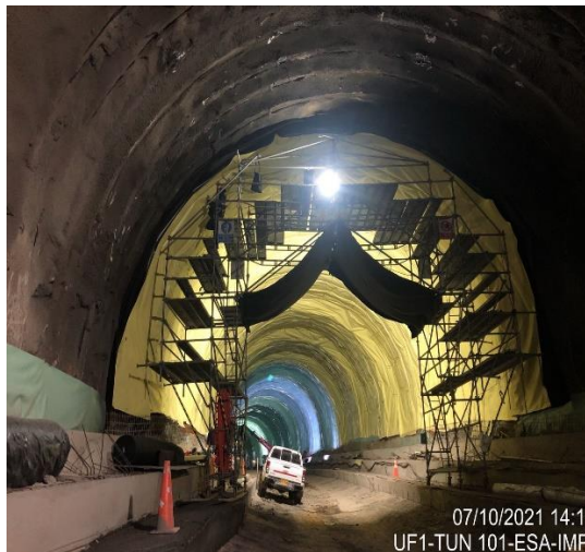
Ilustración 12 Postura de andamio en nueva sección
