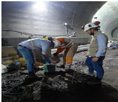
Ilustración 16 Control a dosificaciones de impermeabilización
