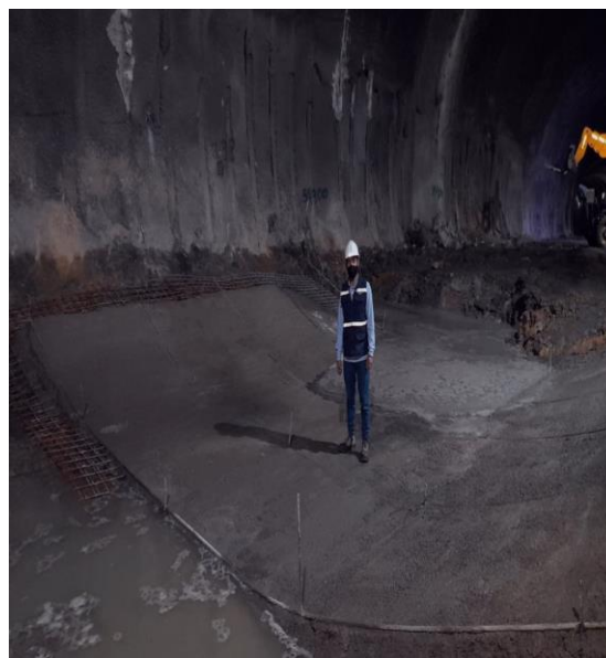
Ilustración 24 Supervisión Contra bóveda
