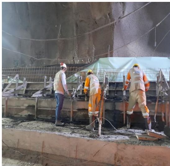
Ilustración 14 Supervisión a proceso de fundida viga base
