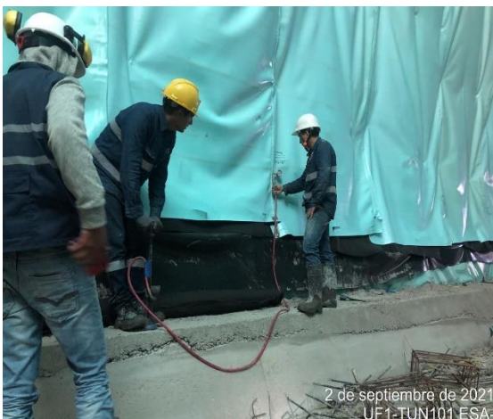
Ilustración 7 Pruebas de estanqueidad en geo membrana en PVC
