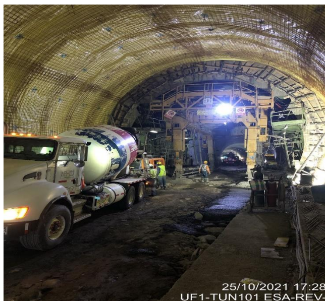
Ilustración 23 Instalacion malla electro soldada
