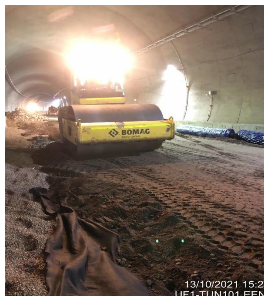
Ilustración 26 Compactación de base con Vibro compactador
