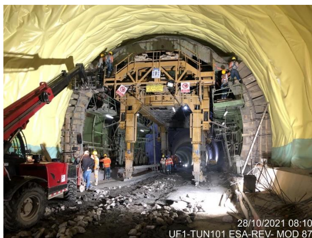
Ilustración 23 Instalacion malla electro soldada
