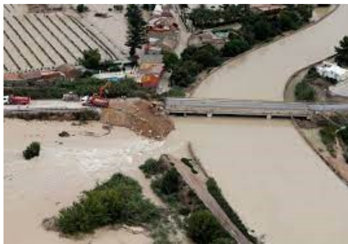
Figura 11 Ríos sin espacio debido a construcciones
