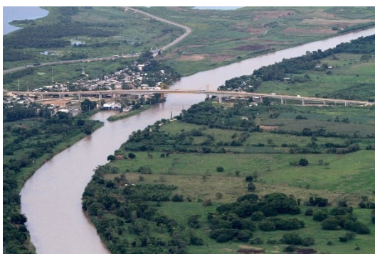
Figura 54 Implementación de Diques
