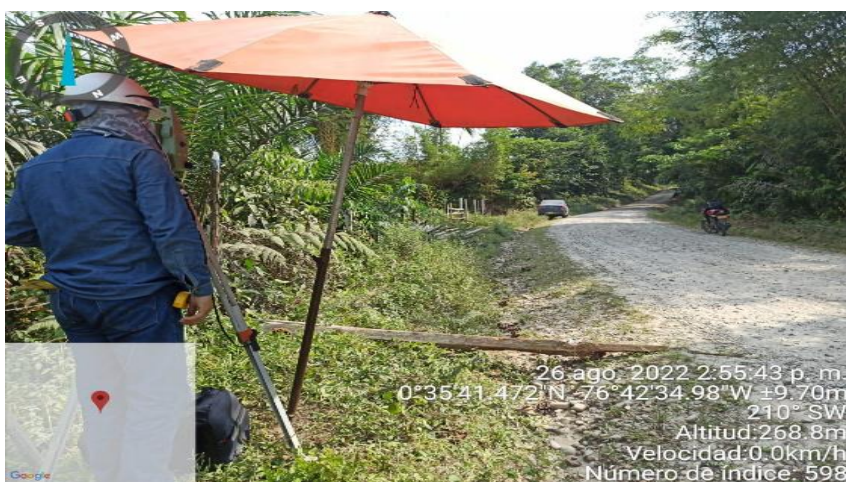
Ilustración 5 Localización y replanteo del eje de la vía. Fuente: propia
