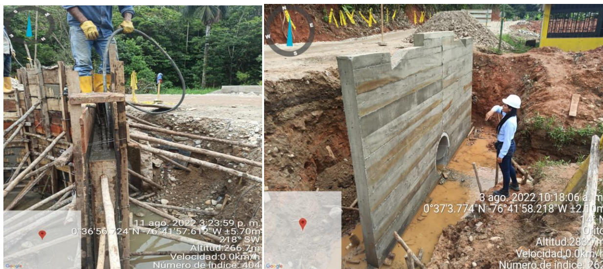
Ilustración 21 Fundición de concreto 3000 psi, proceso de vibrado y acabado de cabezal alcantarillas. Fuente: Propia
