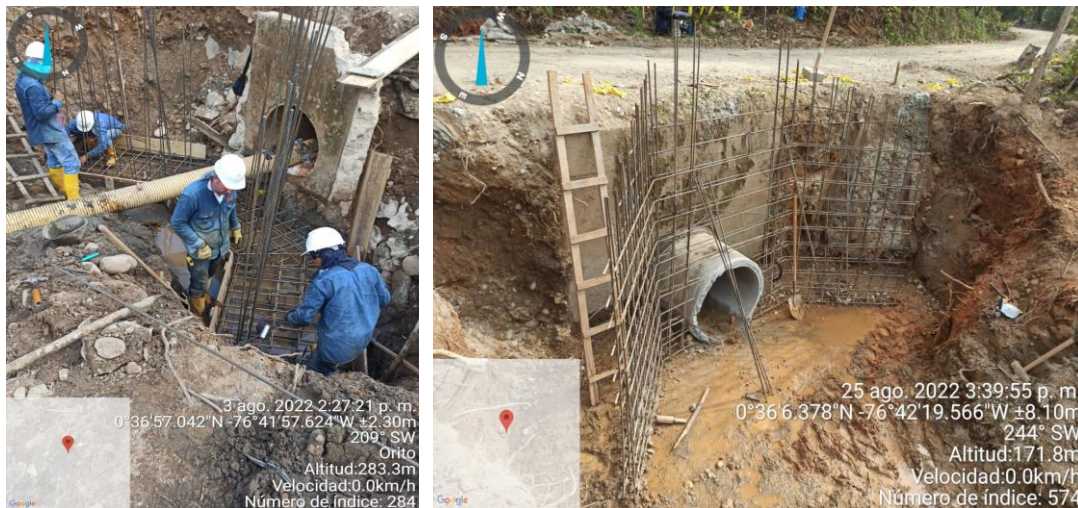
Ilustración 24 Armado y amarre de acero de refuerzo para zarpa y cabezal completo. Fuente: propia
