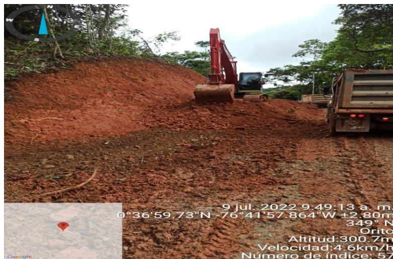
Ilustración 26 Transporte de material de desalojo en corte de talud. Fuente: propia
