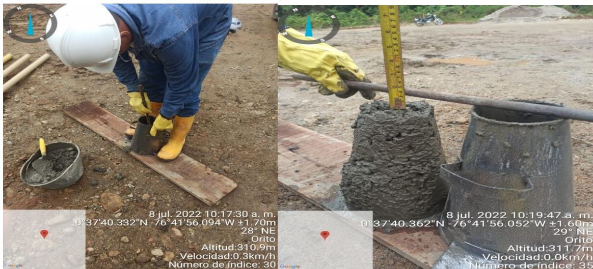
Ilustración 27 Ensayo de asentamiento del concreto empleado en obras de drenaje, tipo D, 3000 psi
