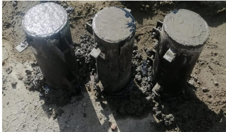
Fotografía 10. Muestra de concreto de viga de cimentación en camisas metálicas
