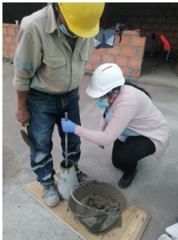
Fotografía 7. Compactación de la mezcla con varilla de acero punta redonda
