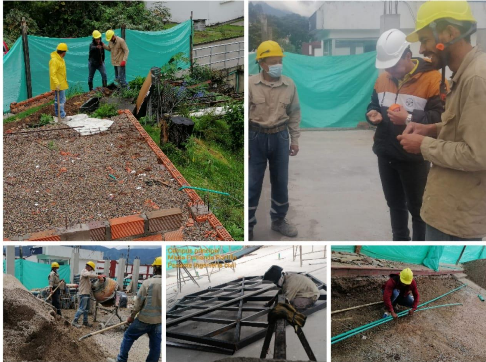
Fotografía 5. Elementos de protección personal EPP
