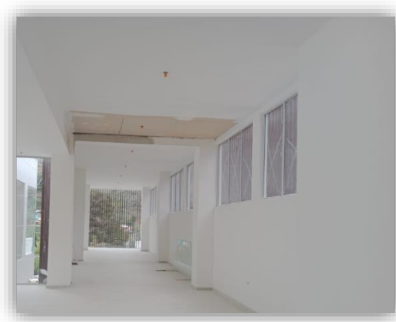
Ilustración 26. Muros reales en obra.
