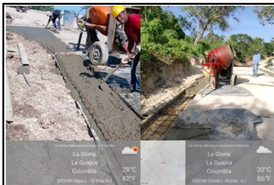
Figura 21 Concreto para cuneta resistencia 21Mpa.
