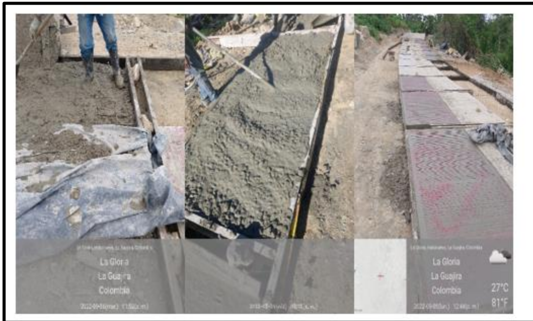
Figura 17 Placa Huella en Concreto de 21Mpa
