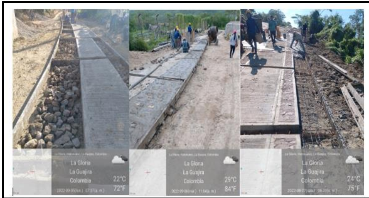
Figura 18 Concreta resistencia 14mpa (g) (ciclópeo)
