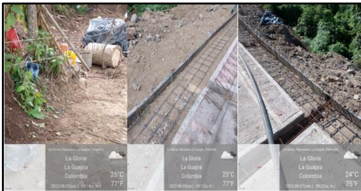
Figura 20 Acero de refuerzo fy 4200 Mpa para alcantarillas.
