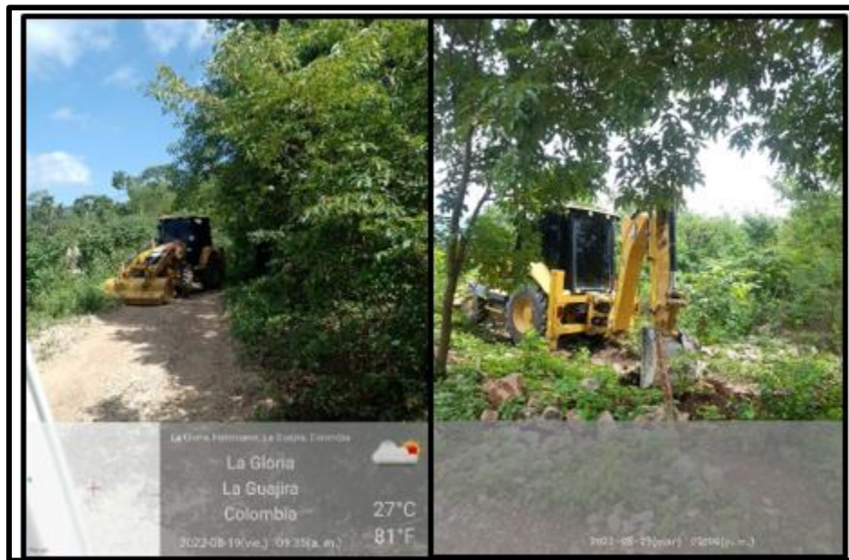
Figura 12 Descapote de terreno.
