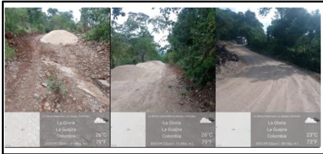
Figura 15 Conformación de calzada existente con adición de material granular
