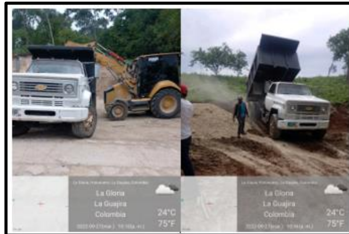
Figura 14 Cargue y transporte de materiales provenientes de la excavaciones y derrumbes
