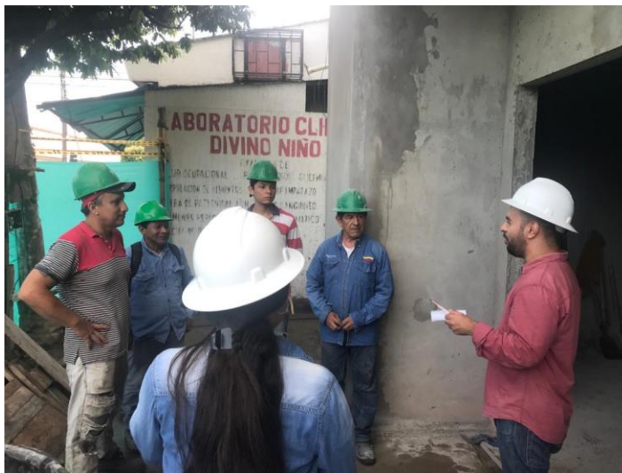
Ilustración 8. Charla de seguridad en la obra.
