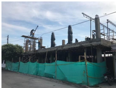
Ilustración 25. Curado de columnas con película de plástico.
