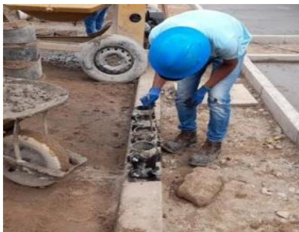
Ilustración 20. Muestras para ensayo de resistencia a la compresión.
