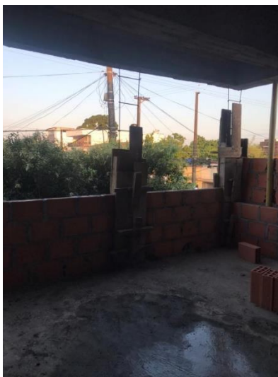
Ilustración 24. Colocación de concreto en columnetas.
