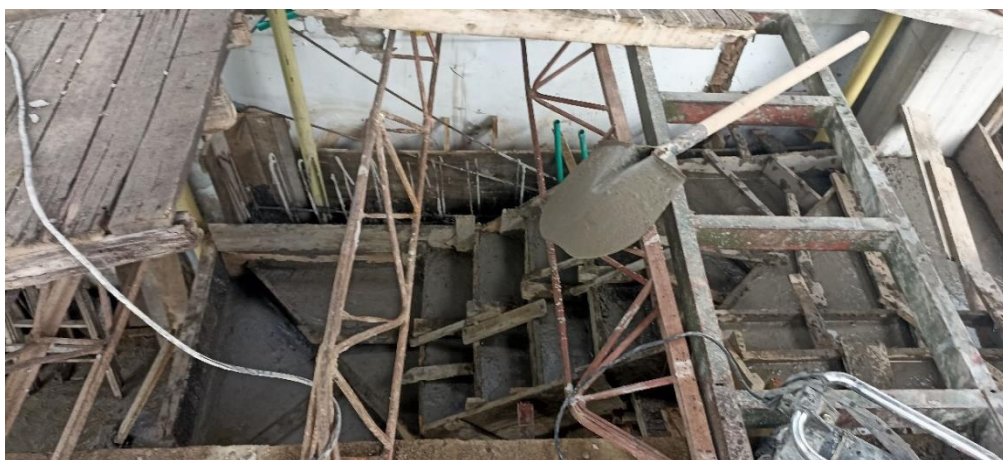
Ilustración 23. Colocación de concreto en las escaleras.
