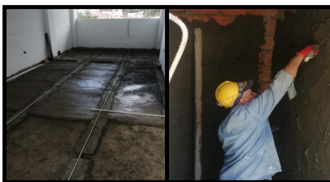
Ilustración 33, aplicación de concreto en obra
