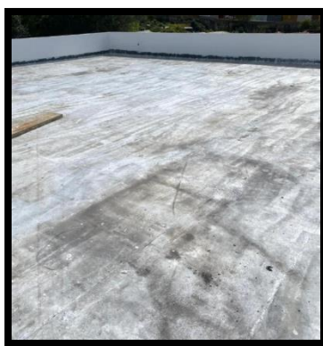
Ilustración 24, pintura en terraza
