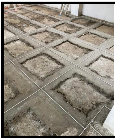
Ilustración 26, aplicación de piso en mortero
