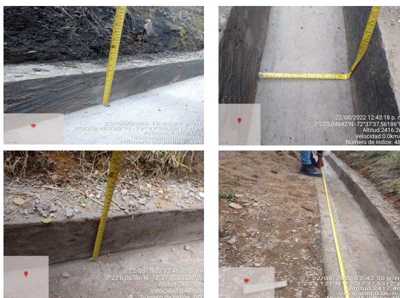
Figura 38. Realización de mediciones de los canales de aguas lluvias con cinta métrica
