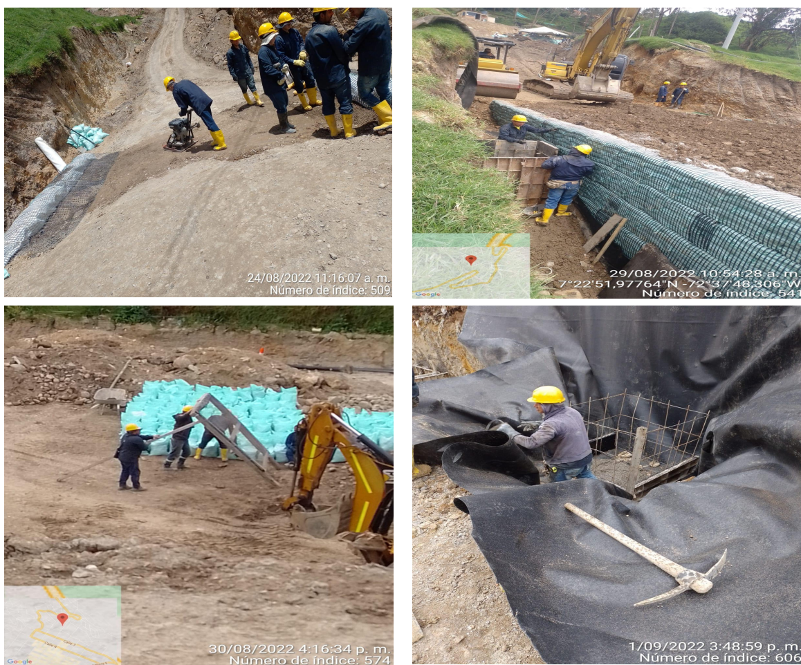
Figura 40. Registro fotográfico para la inspección de obra
