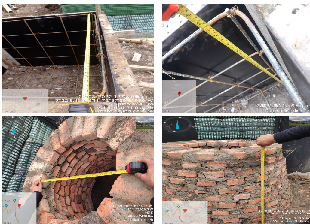
Figura 37. Realización de mediciones caja filtro red de lixiviado
