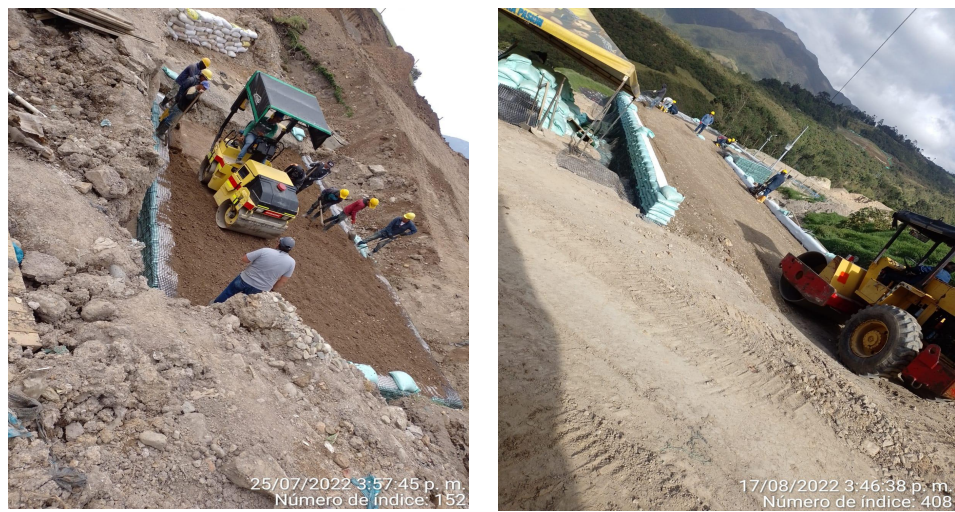
Figura 20. Modificación en la energía de compactación con el cambio de la vibro compactadora de rodillo
