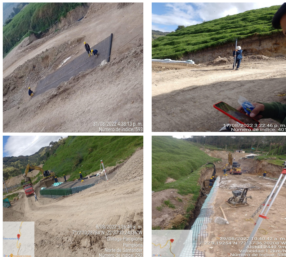
Figura 39. Medición y replanteo topográfico muro en tierra armada
