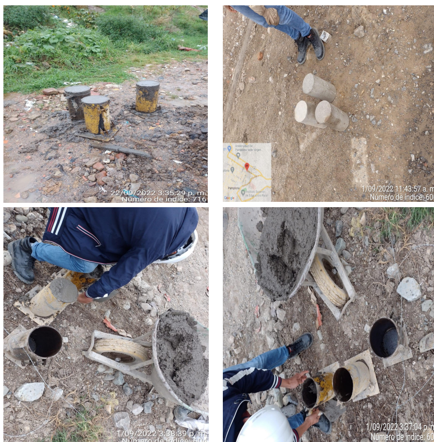
Figura 24. Realización de muestras de cilindros de concreto en campo.
