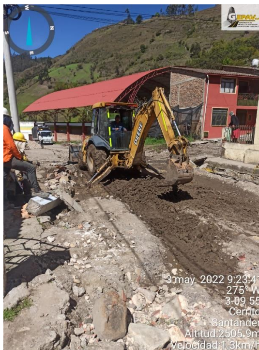
Figura 10 Excavaciones sin clasificar de explanaciones y canales
