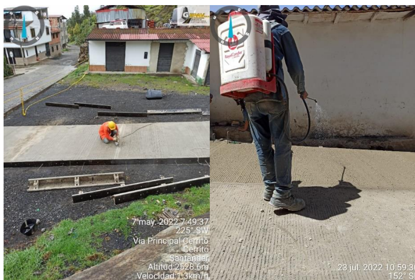
Figura 17 Corte de junta de dilatación de las losas, y aplicación de anti sol
