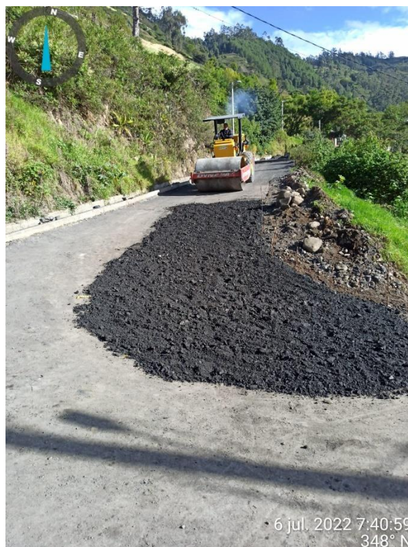
Figura 12 Rehabilitación de la subrasante
