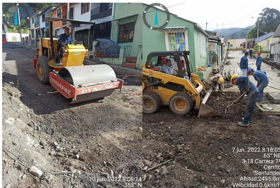
Figura 23 Vibro compactador y minicargador
