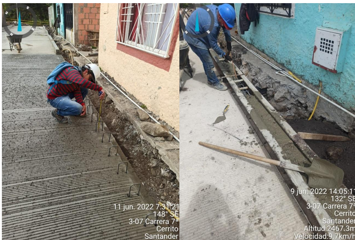
Figura 18 Armado y fundida de bordillos de confinamiento
