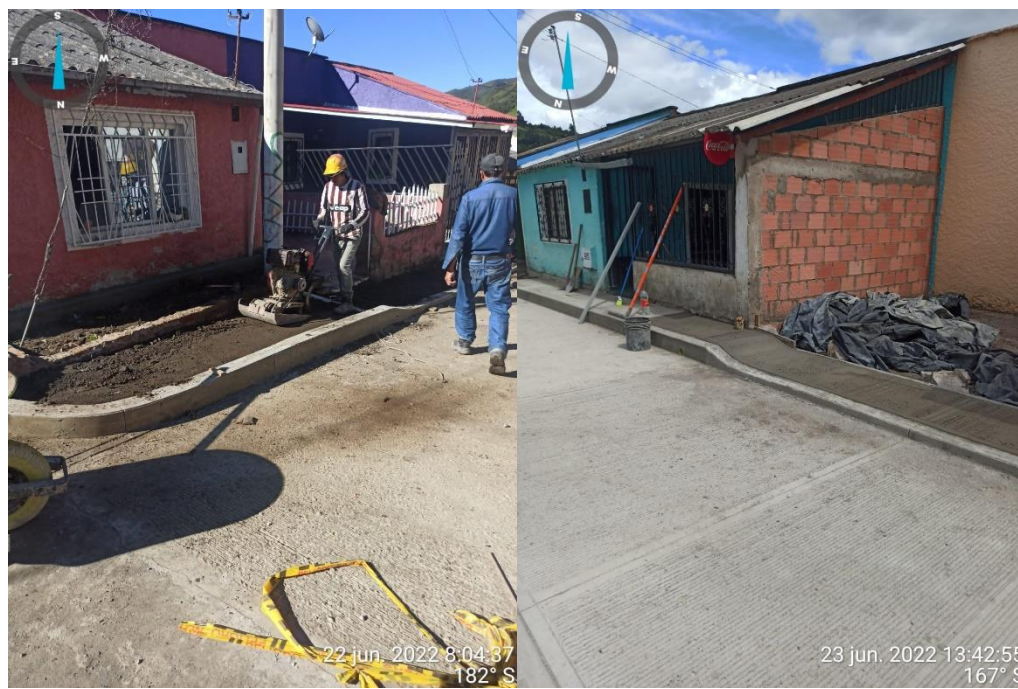
Figura 19 Replanteo, fundida y acabado de andenes
