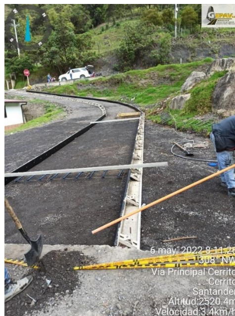
Figura 13 Armado de Formaleta y acero de refuerzo
