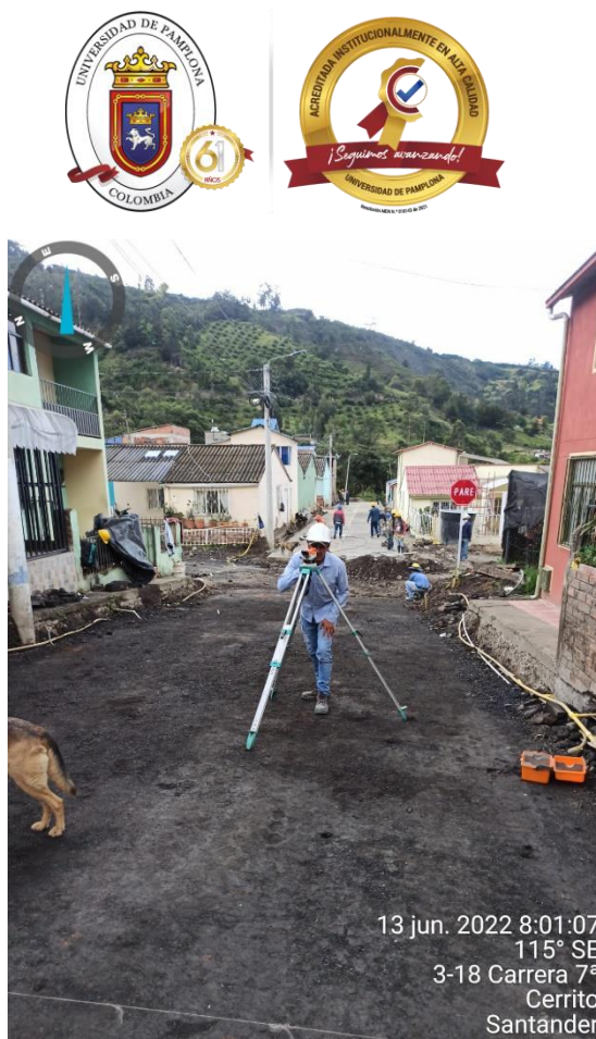
Figura 9 Nivelación y replanteo
