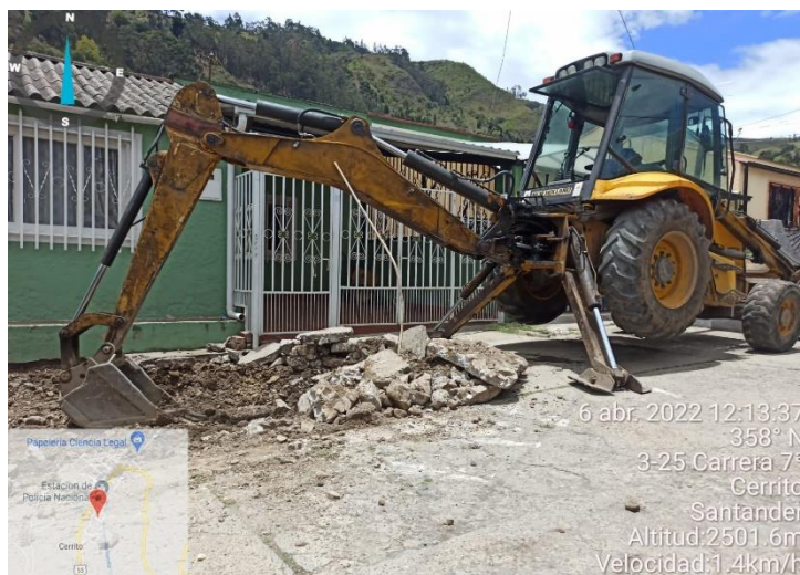
Figura 8 Demolición de losas de pavimento rígido
