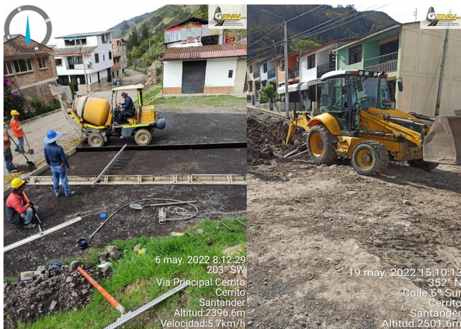
Figura 22 Retroexcavadora y Carmix
