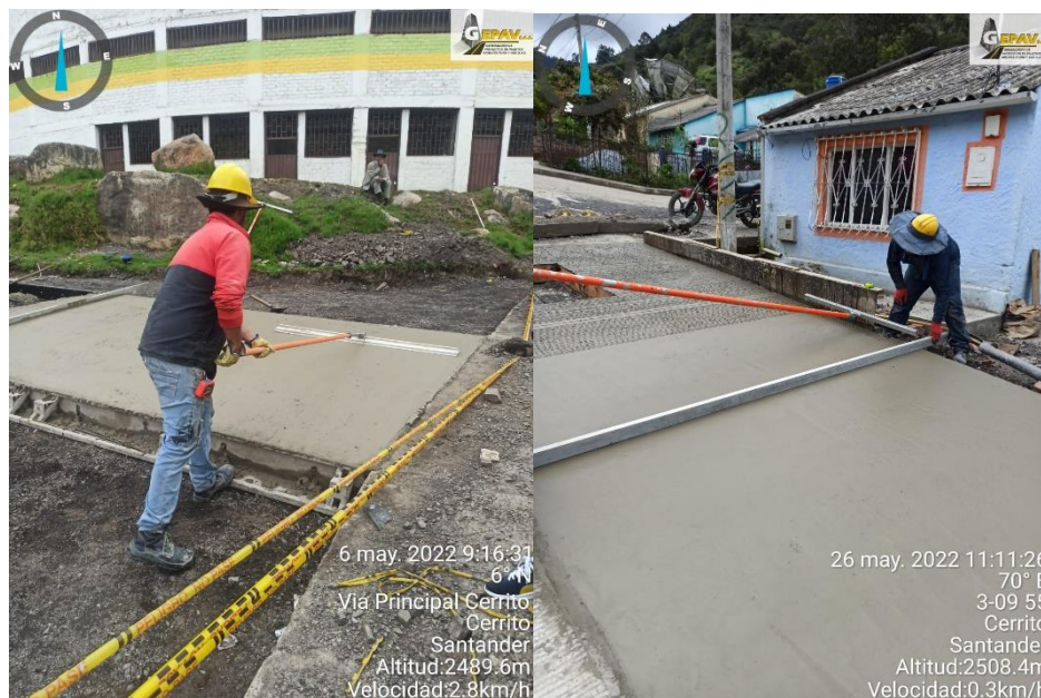
Figura 16 Acabado y texturizado de la losa
