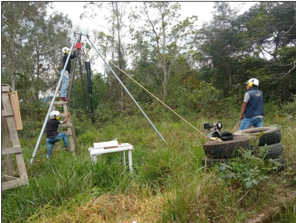
Ilustración 22. ensayos de SPT en campo fuente (propia).
