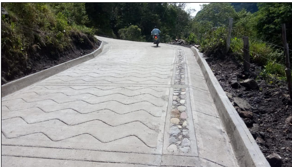
Ilustración 48. Placa huella finalizada tramo 1. fuente (propia).
