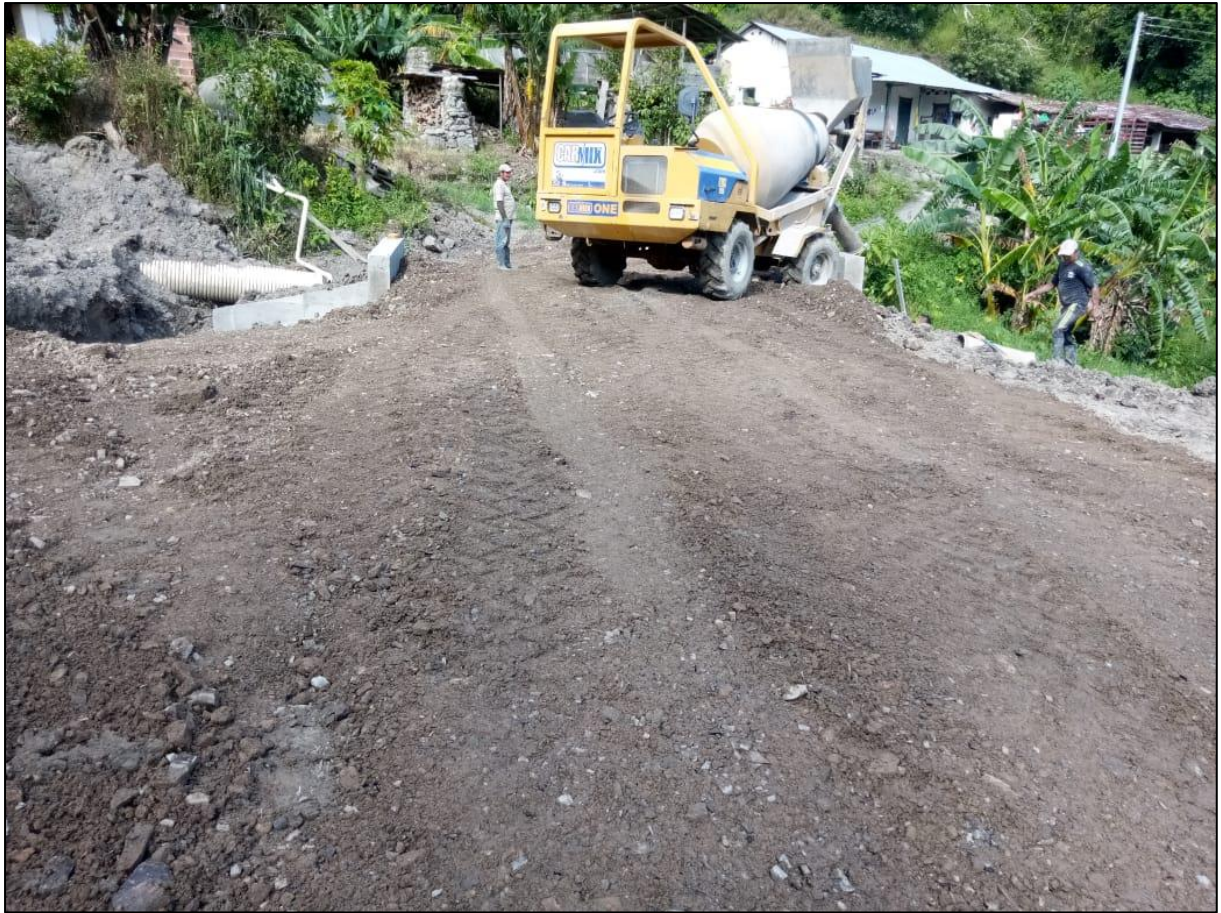
Ilustración 50. Box culvert finalizado tramo 1. fuente (propia).
