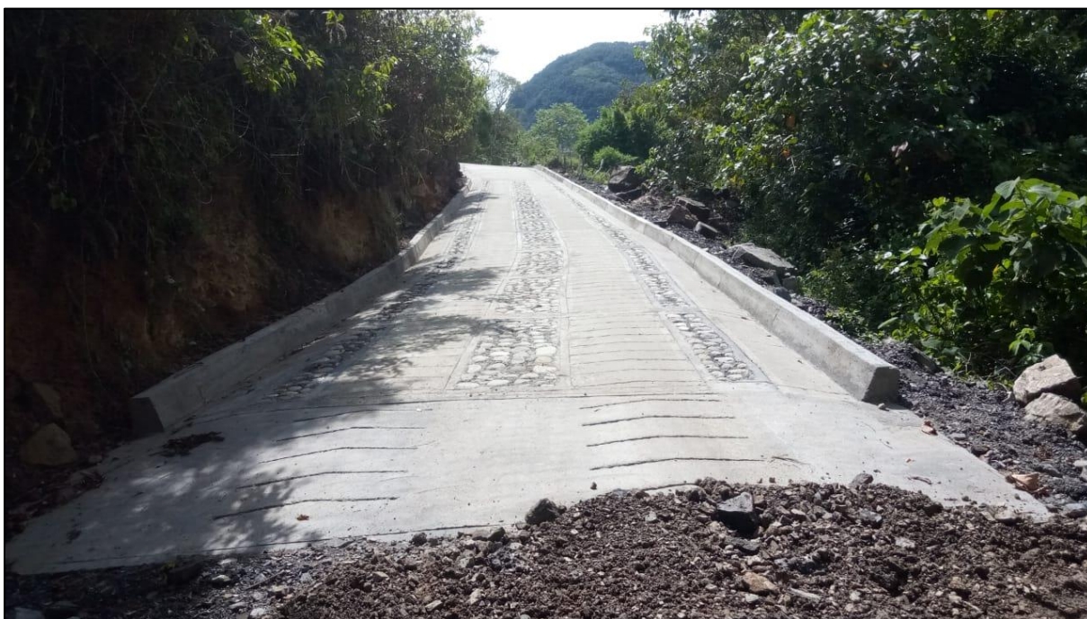
Ilustración 49. Placa huella finalizada tramo 1. fuente (propia).
