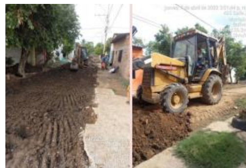
Figura 14. Nivelación del terreno
