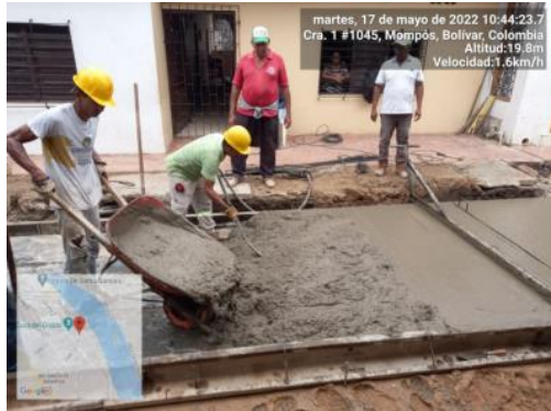
Figura 17. Fundida de losas en concreto
