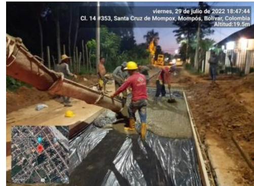
Figura 18. Fundida de losa con concreto premezclado
