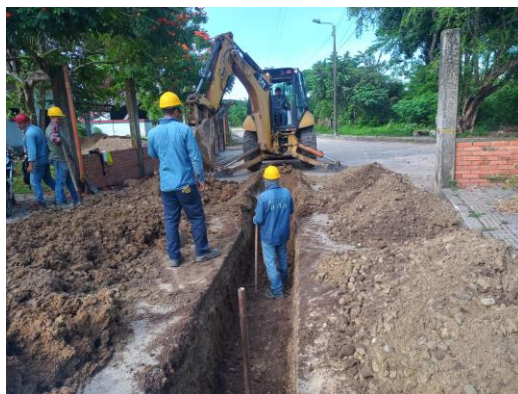
Ilustración 33: Excavación mecánica en material
