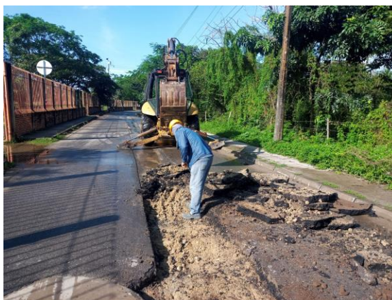
Ilustración 32: Demolición de pavimento flexible con máquina.
