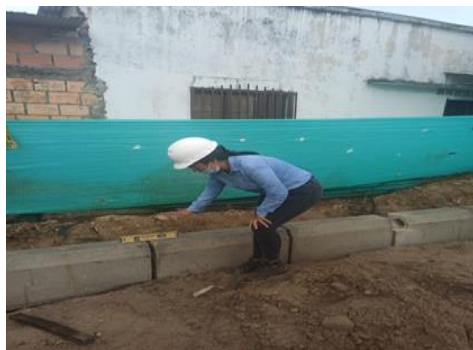
Ilustración 10: instalación de sardineles prefabricados de 3500 psi
