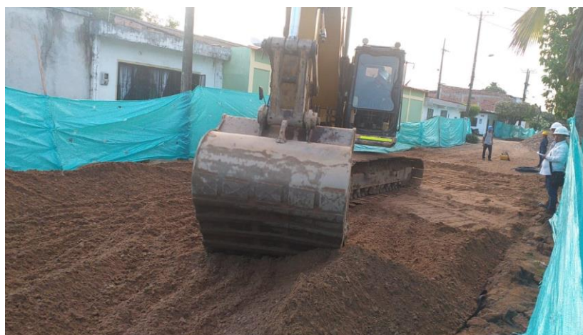
Ilustración 8: Extendido de base granular.
