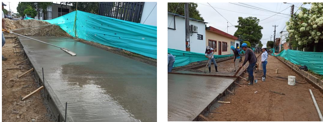
Ilustración 9: losa de concreto y alisado de la placa.
