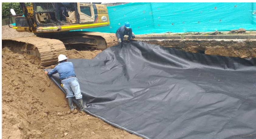
Ilustración 7: instalación de geotextil t-2400 instalado.
