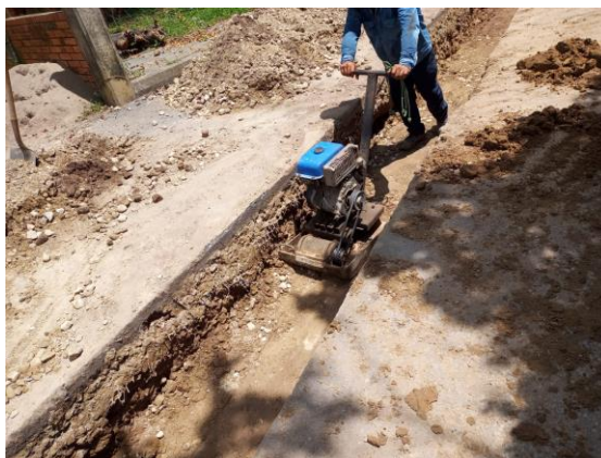
Ilustración 35: compactación de material común con rana.
