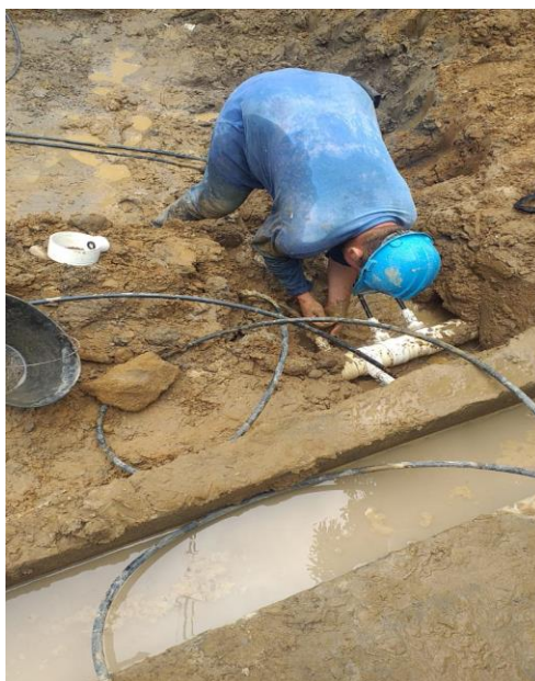
Ilustración 11: Reparación acometida domiciliaria acueducto.
