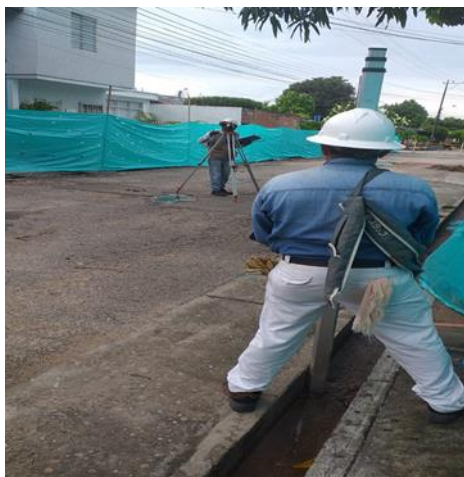
Ilustración 4: localización y replanteo.
