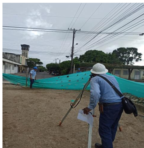
Ilustración 4: localización y replanteo.
