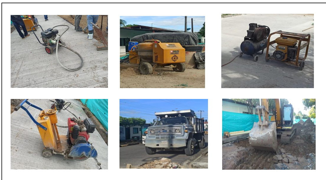
Ilustración 21: verificación de máquina, equipos y vehículos.
