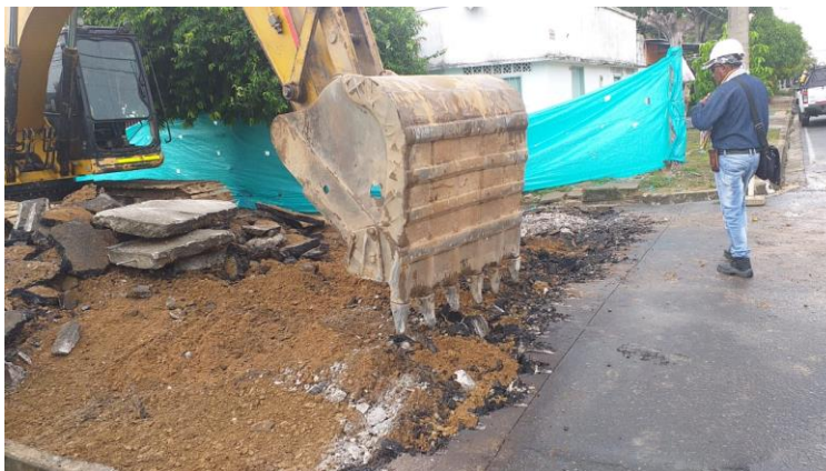
Ilustración 5: Excavación mecánica en material común
