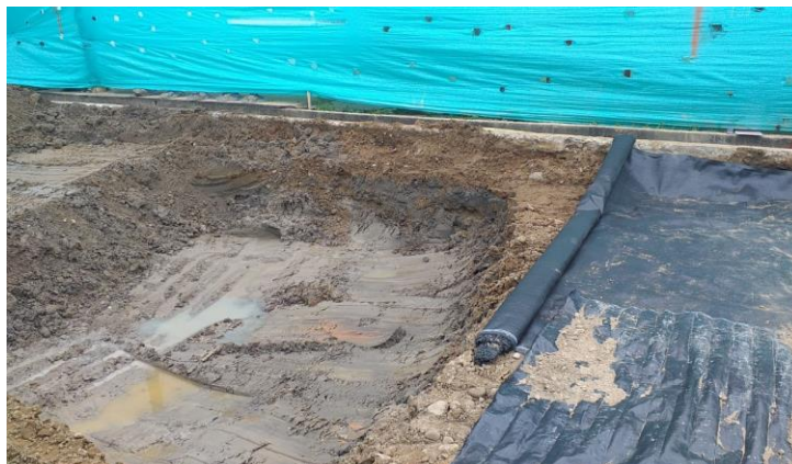
Ilustración 6: reparación de fallo
