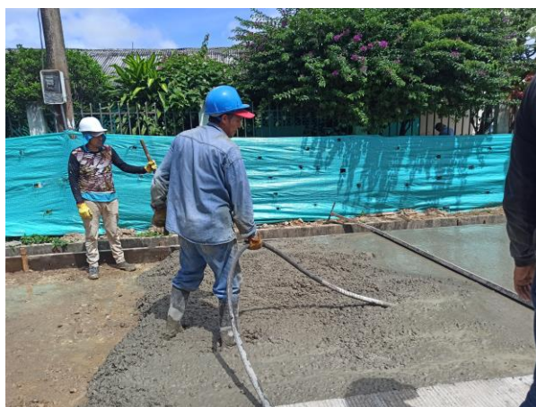
Ilustración 26: vibrado del concreto.
