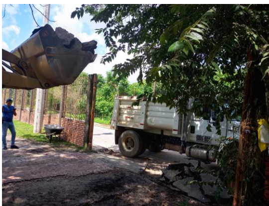
Ilustración 34: Cargue y retiro de escombros mecánico.
