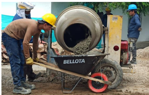
Ilustración 25: verificación de la mezcla, fuente propia
