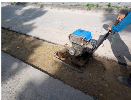
Ilustración 36: compactación de subbase granular con rana
