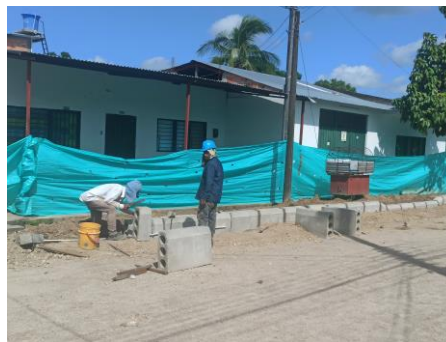
Ilustración 10: instalación de sardineles prefabricados de 3500 psi
