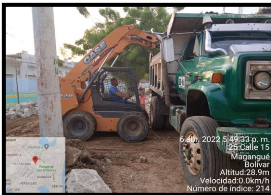
Ilustración 65: Cargue y transporte de material residual de construcción. Fuente: Propia.
