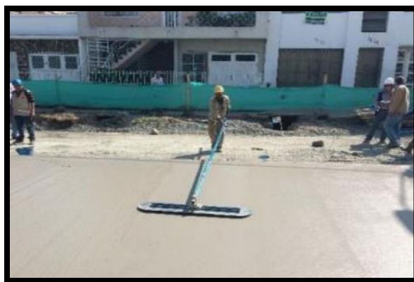
Ilustración 68: Concreto hidráulico para losas de pavimentos. Fuente: Propia.
