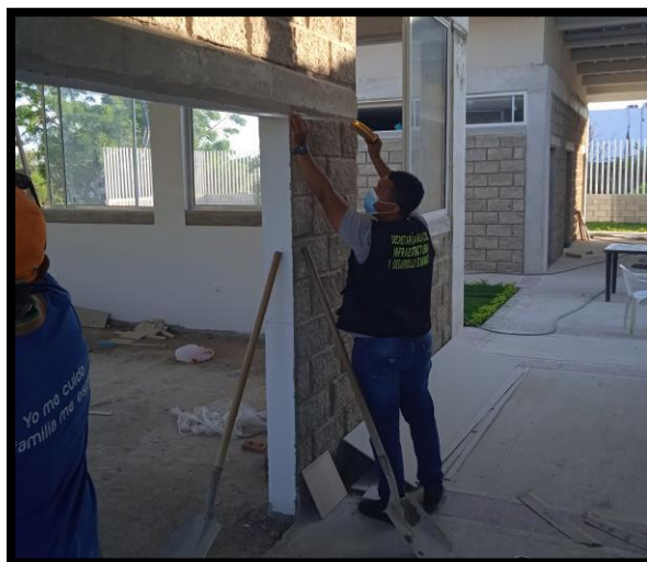
Ilustración 38: Mediciones de muro y puertas. Fuente: Propia.
