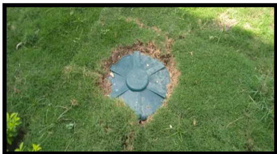
Ilustración 47: Suministro de trampa de grasa plástica de 250Lts. Fuente: Propia.
