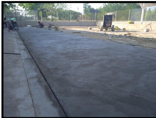
Ilustración 28: Placa de concreto de 4000 PSI (Parqueadero) Fuente: Propia.
