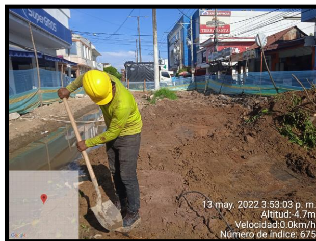
Ilustración 74: Utilización de las EPP en obra. Fuente: Propia.
