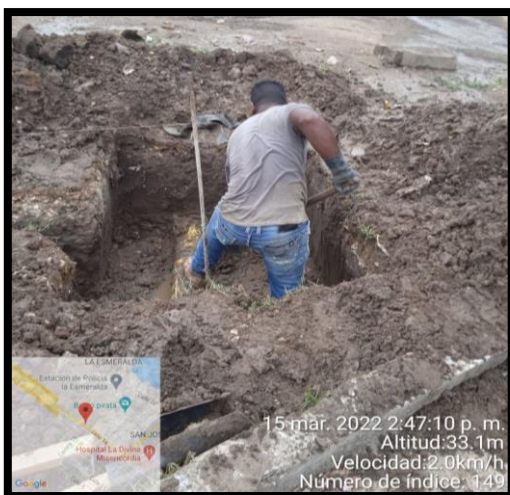
Ilustración 43: Excavación de caja de inspección 1 X 1 m. Fuente: Propia.
