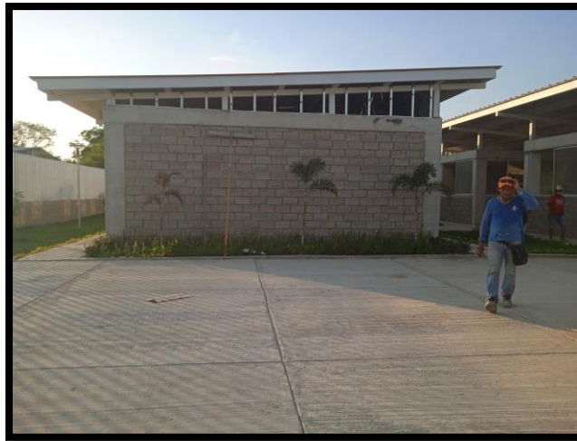
Ilustración 27: Placa de concreto de 4000 PSI (Parqueadero). Fuente: Propia.
