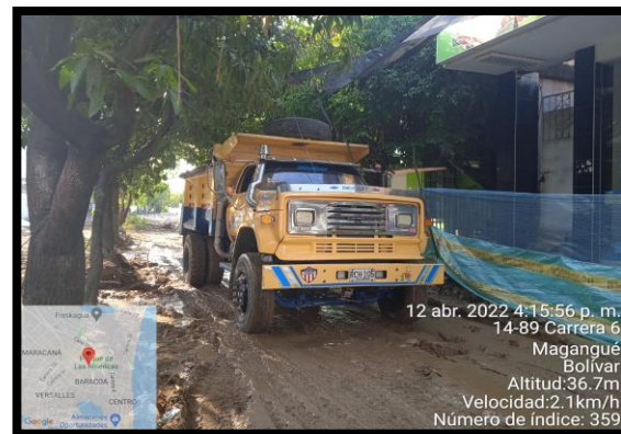
Ilustración 64: Cargue y transporte de material residual de construcción. Fuente: Propia.
