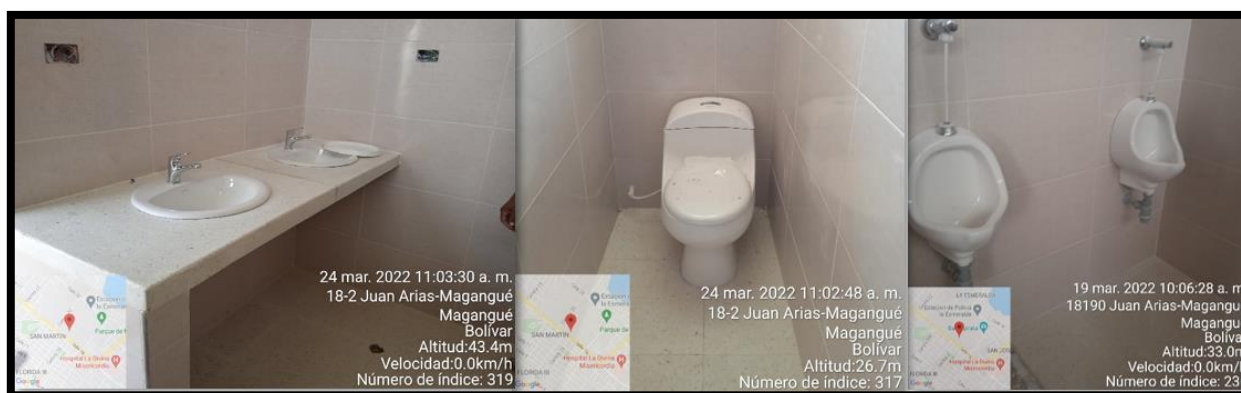
Ilustración 42: Suministro de aparatos sanitarios (Inodoro con fluxómetro, lavamanos y Orinales cerámicos de colgar).
