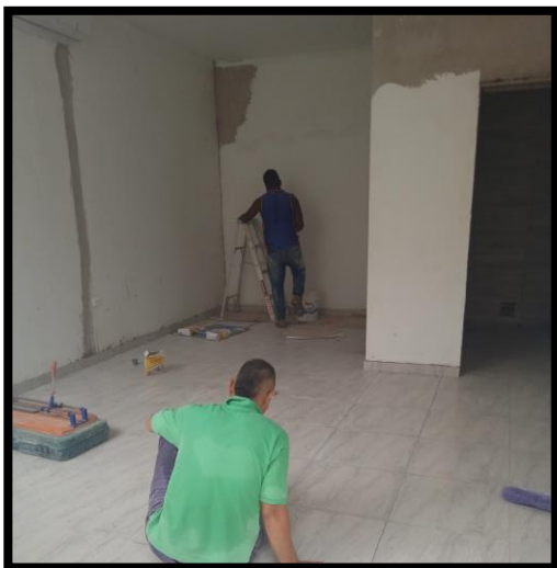
Ilustración 36: Actividad de embaldosado. Fuente: Propia
