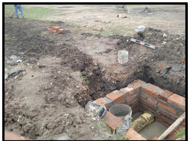
Ilustración 44: Construcción de caja de inspección 1 X 1 m. Fuente: Propia.
