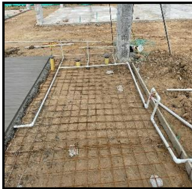
Ilustración 57: Ubicación de la malla electrosoldada. Fuente: Propia
