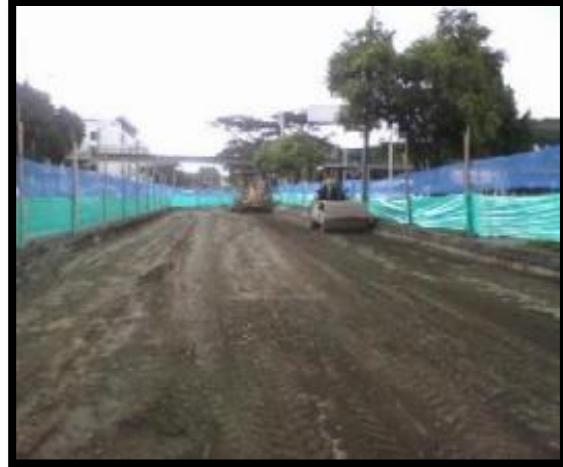
Ilustración 62: Conformación de calzada existente. Fuente: Propia.
