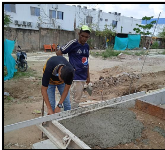
Ilustración 41: Medición de loza de pavimento f'c=4000 Psi. Fuente: Propia.
