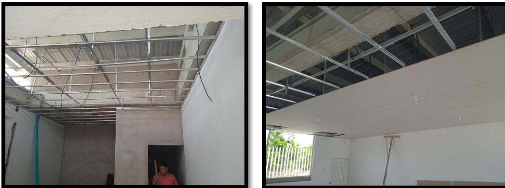
Ilustración 25: Instalación de cielo raso. Fuente: Propia.
