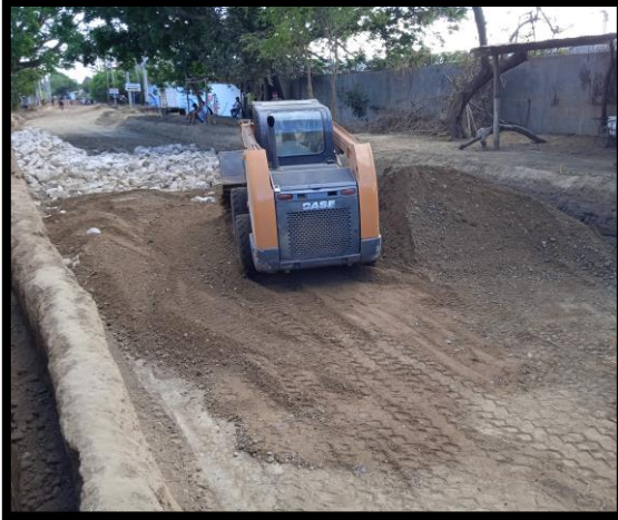
Ilustración 63: Conformación de calzada existente. Fuente: Propia.
