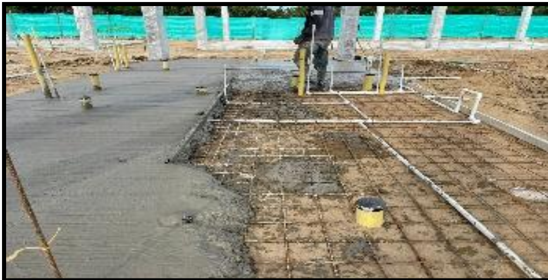
Ilustración 55: Vaciado de la placa de contrapiso. Fuente: Propia
