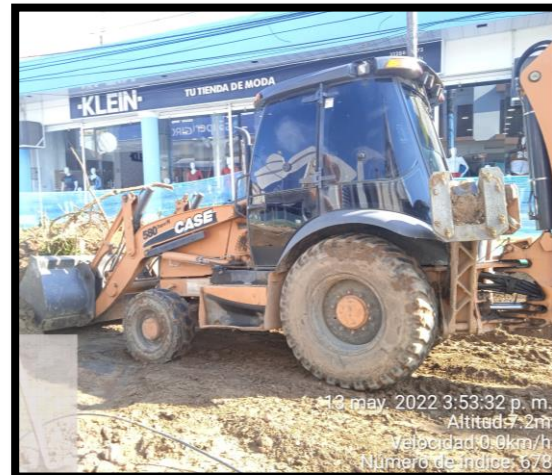
Ilustración 60: Excavación con maquinaria. Fuente: Propia
