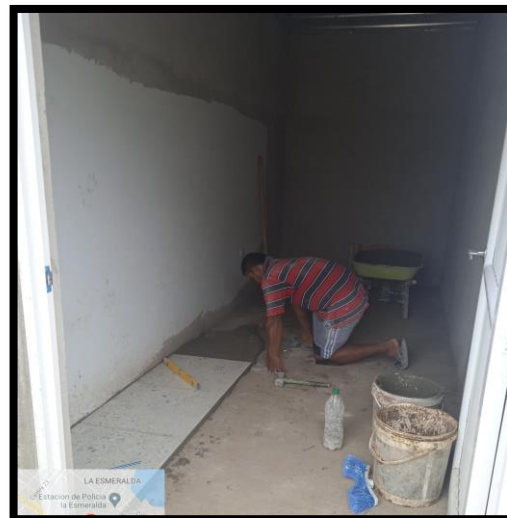
Ilustración 35: Actividad de embaldosado. Fuente: Propia
