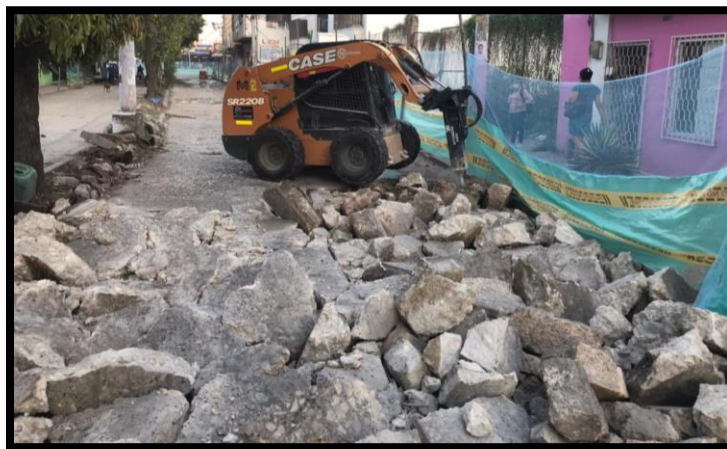
Ilustración 59: Demolición con minicargador. Fuente: Propia.
