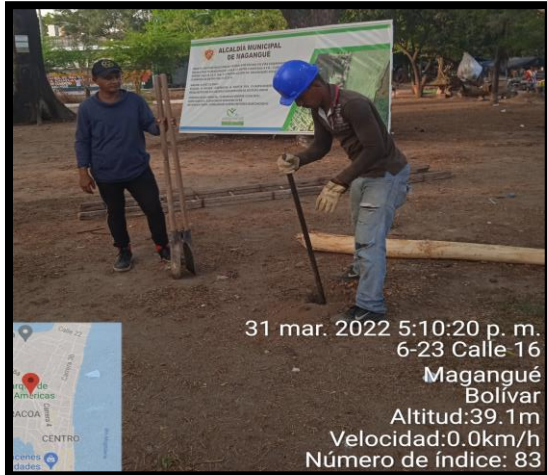
Ilustración 61: Excavación manual. Fuente: Propia.
