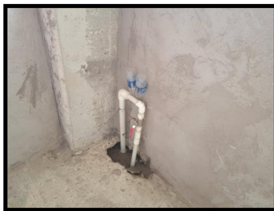
Ilustración 49: Suministros de equipo de bombeo. Fuente: Propia.
