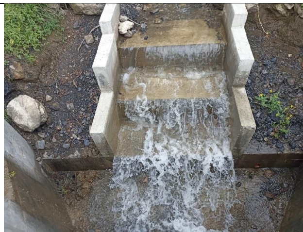
Ilustración 10 Dissipador
