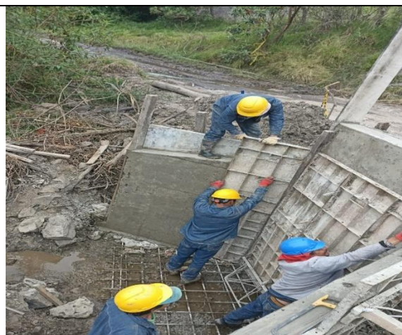
Ilustración 24 Desformaleteo
