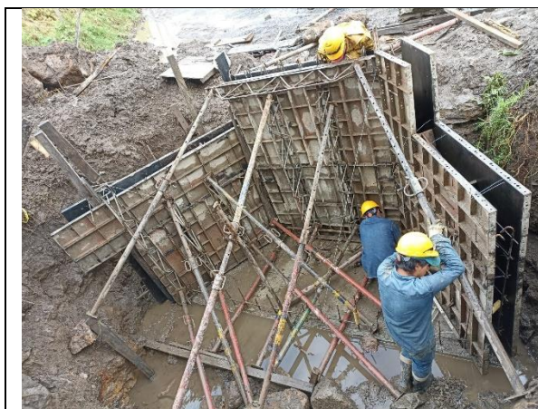
Ilustración 29 Encofrado
