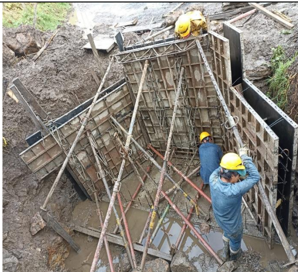
Ilustración 7 Encofrado de alcantarilla
