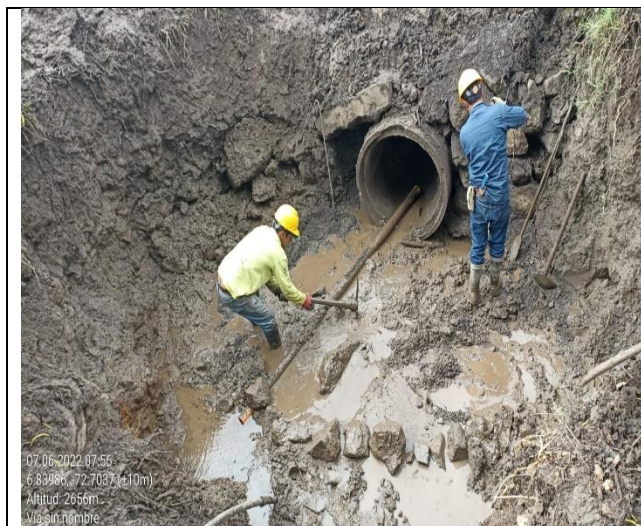
Ilustración 27 Nivelación del terreno
