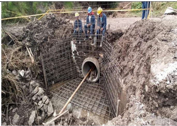
Ilustración 22 Acero alcantarilla
