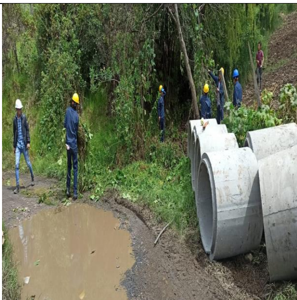
Ilustración 17 Descapote
