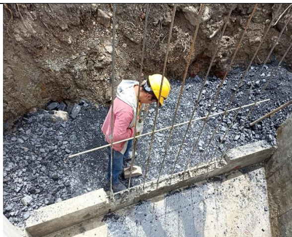
Ilustración 9 Amarre de acero dissipador
