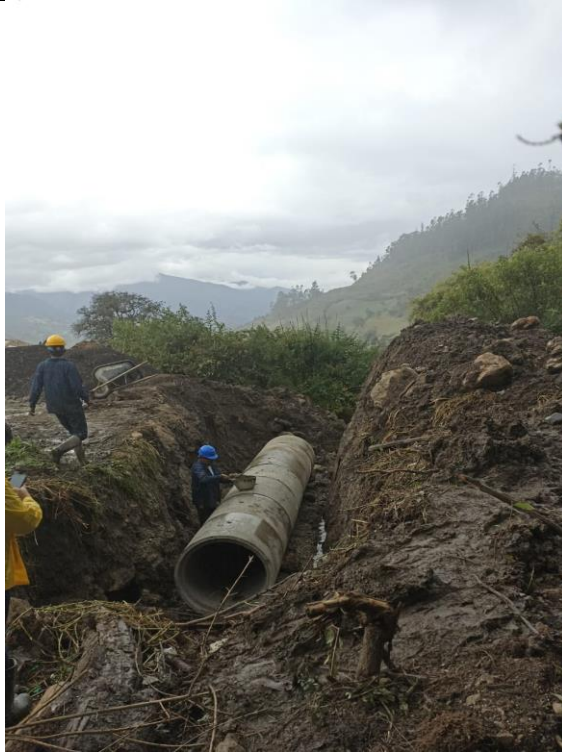
Ilustración 19 Instalación de tubería
