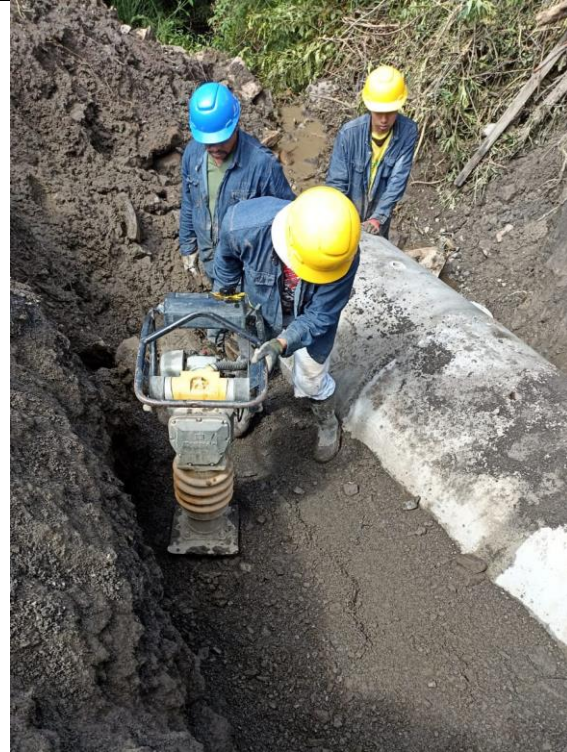
Ilustración 20 Relleno y compactación
