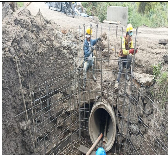
Ilustración 6 Amarre de acero alcantarilla
