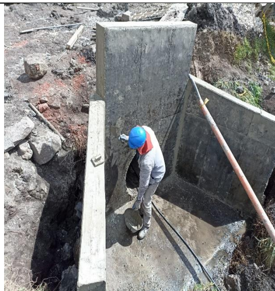
Ilustración 26 Alcantarilla terminada
