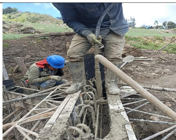
Ilustración 30 Vibrado del concreto
