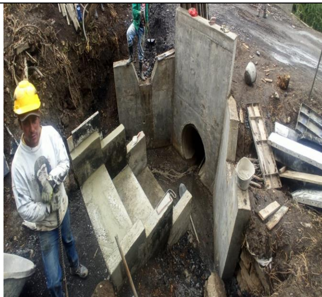
Ilustración 31 Alcantarilla
