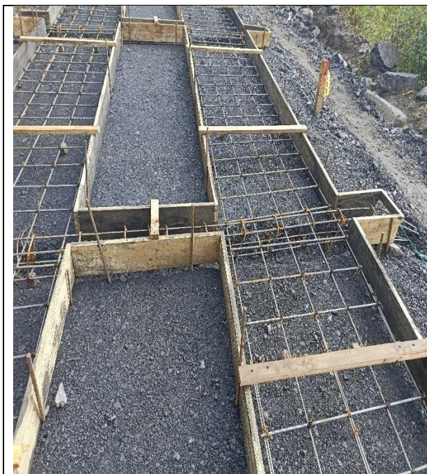
Ilustración 36 Encofrado
