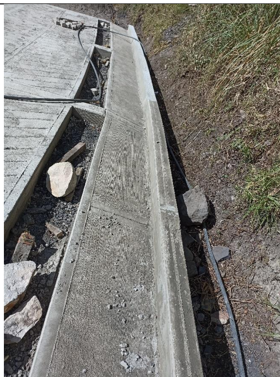
Ilustración 41 Cuneta y bordillo
