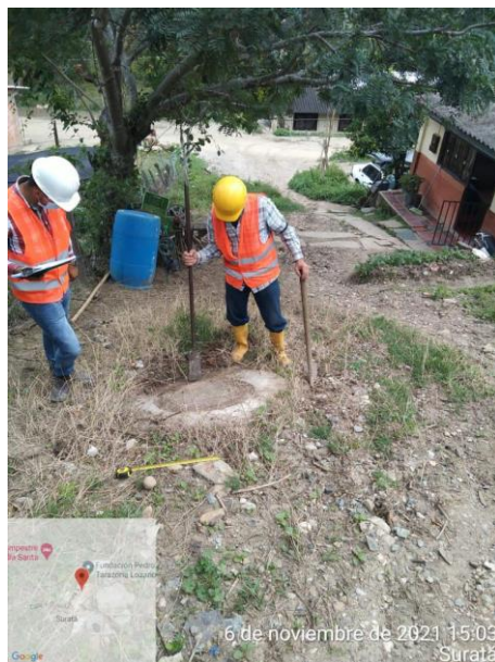
Ilustración 19. Ensayos de Placa para Capacidad Portante del Suelo
