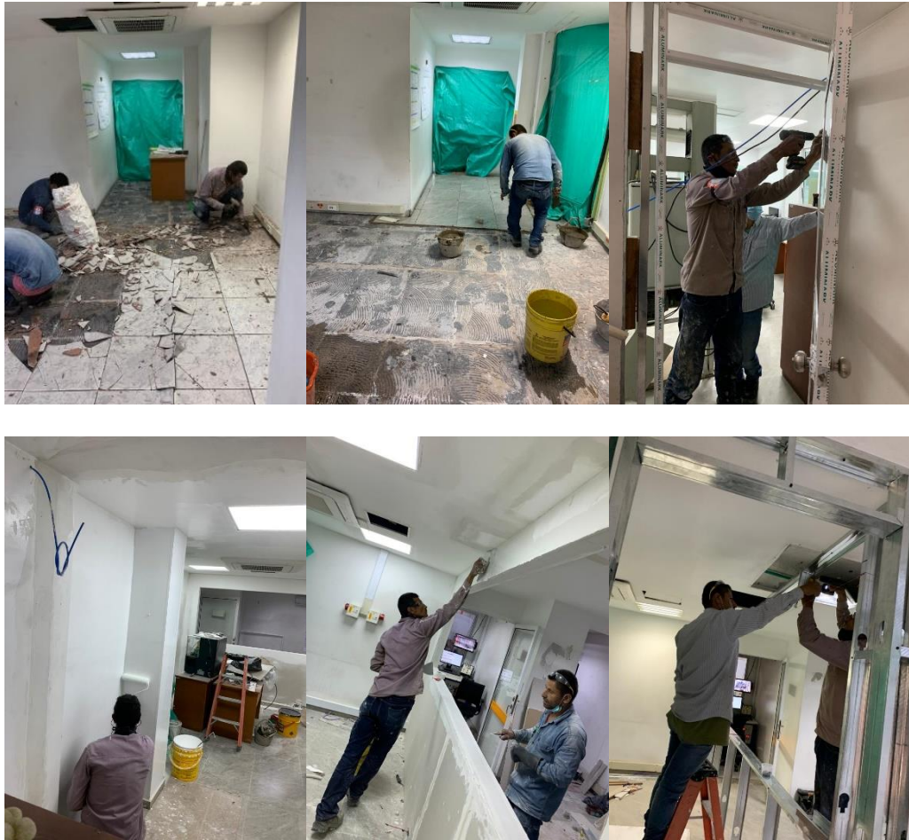
Ilustración 39. Evidencia de Procesos Constructivos
