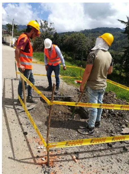
Ilustración 24. Verificación de Profundidad para Ensayos de Placa (Capacidad Portante)
