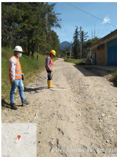
Ilustración 22. Recorrido e Identificación de Redes de Alcantarillado
