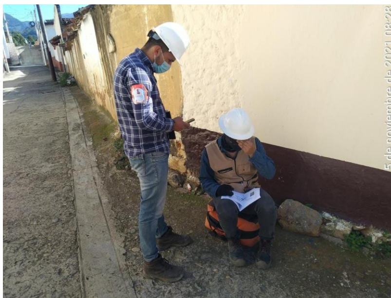
Ilustración 25. Verificación de progreso cuadrilla topográfica
