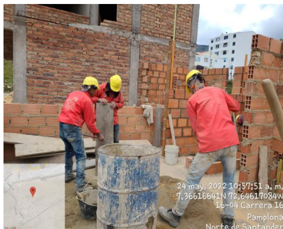
Ilustración 6-Mezcla de concreto y mortero.
