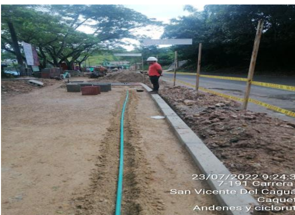
Ilustración 24: instalación de Losetón.
