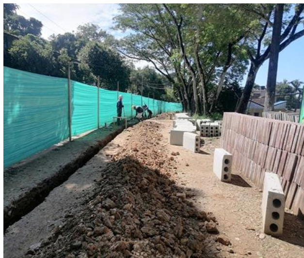
Ilustración 22: Excavación manual.
