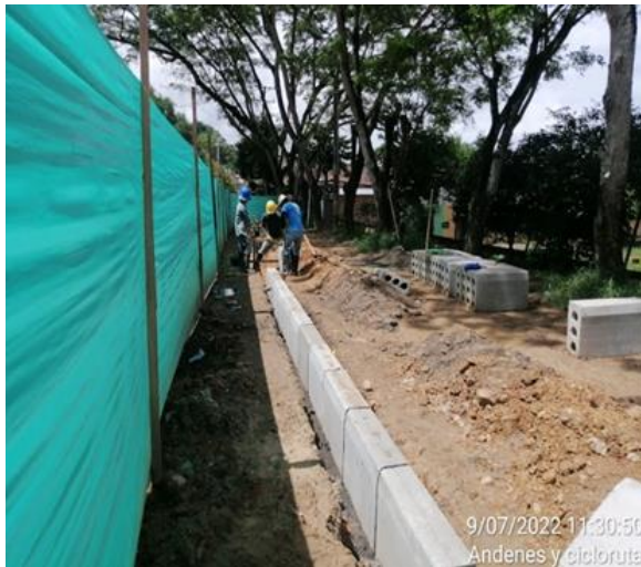
Ilustración 23: Instalación de sardineles.
