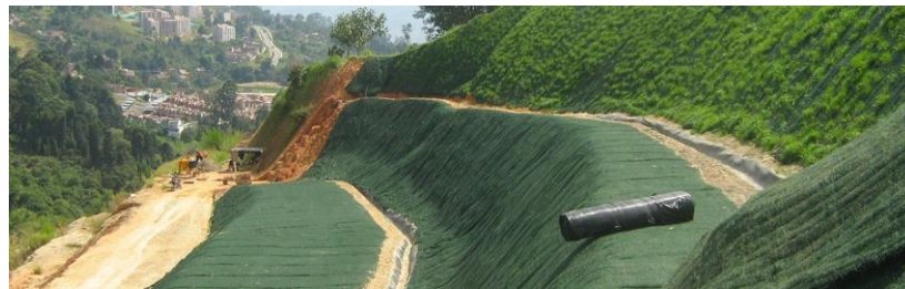
Figura 33 Control de erosión
