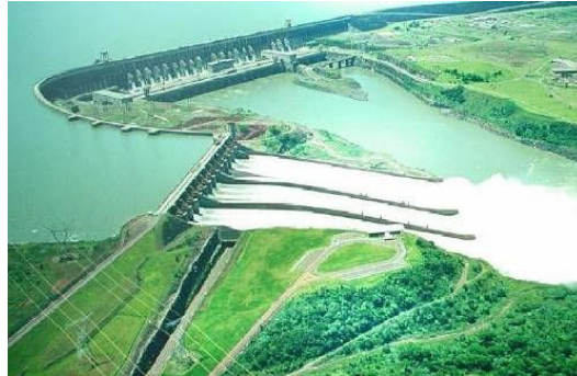
Figura 32 Evacuador de crecidas
