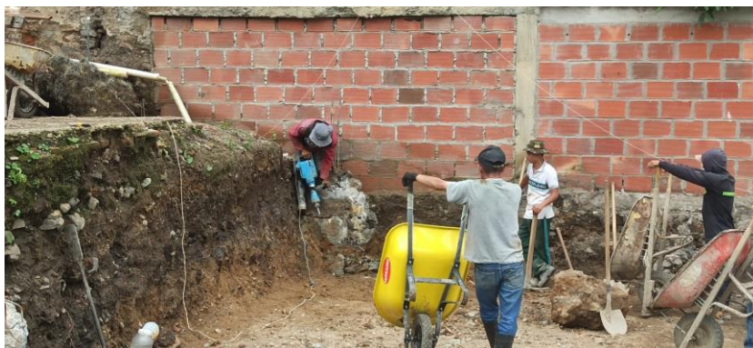
Figura 42. Excavacion para el túnel, profundidad de 2,20 m
