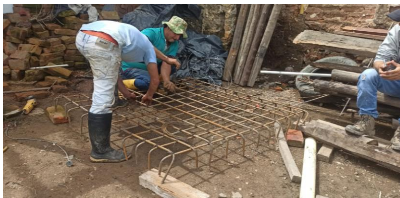
Figura 45. Realización de zapatas
