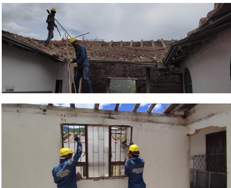
Figura 19. Evidencia de la dotación dada haciendo desmonte de la ventana, y desmonte de la cubierta
