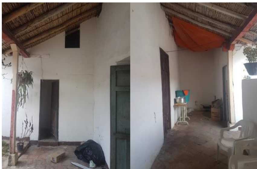
Figura 9. Muros Existentes tomada en 2018.
