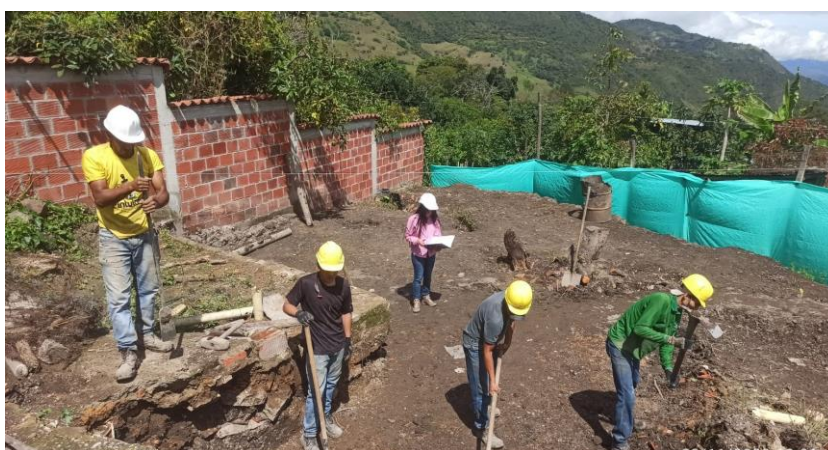
Figura 43. Retiro de material en pared de concreto
