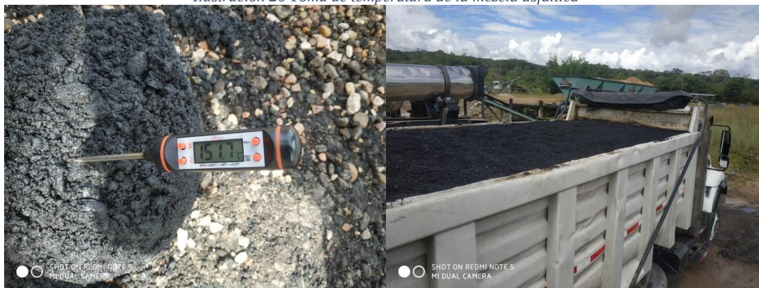
Ilustración 26 Toma de temperatura de la mezcla asfáltica
