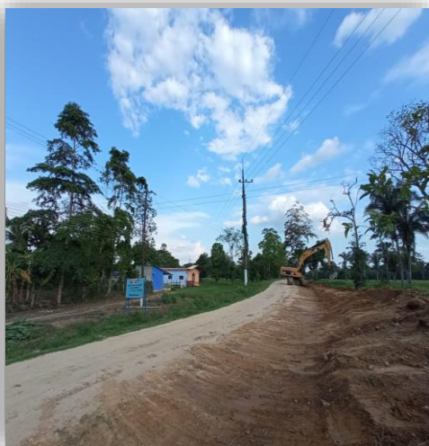
Ilustración 24 conformación de la calzada incluyendo bacheos
