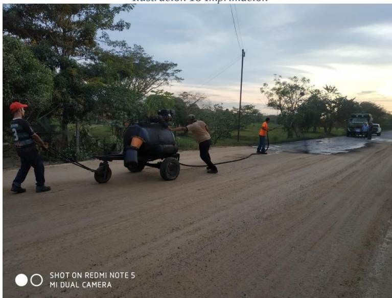
Ilustración 18 Imprimación
