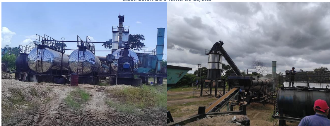
Ilustración 28 Planta de asfalto
