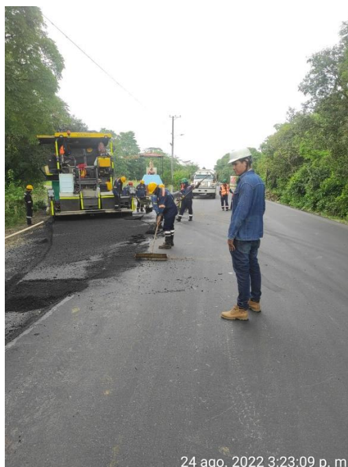
Ilustración 9 Aplicación Mezcla asfáltica
