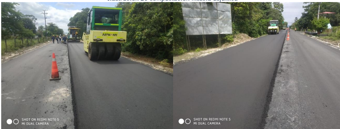
Ilustración 20 compactación mezcla asfáltica
