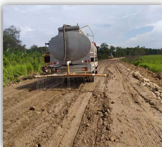
Ilustración 24 conformación de la calzada incluyendo bacheos
