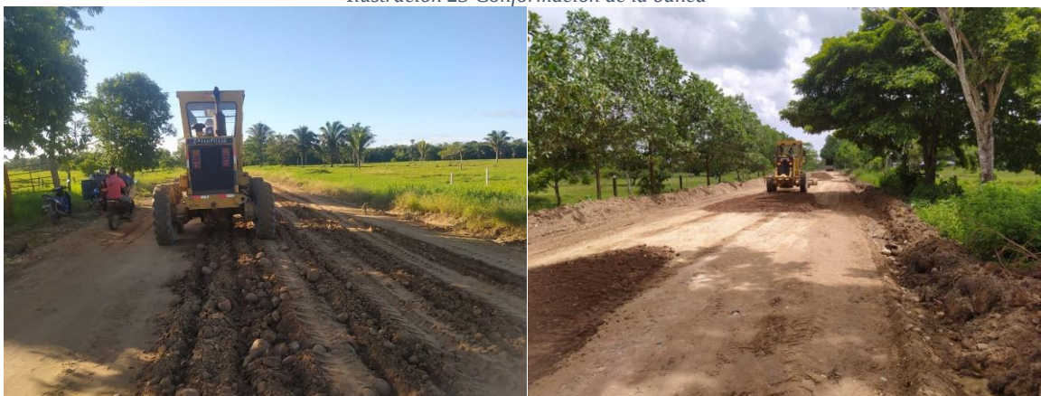
Ilustración 23 Conformación de la banca
