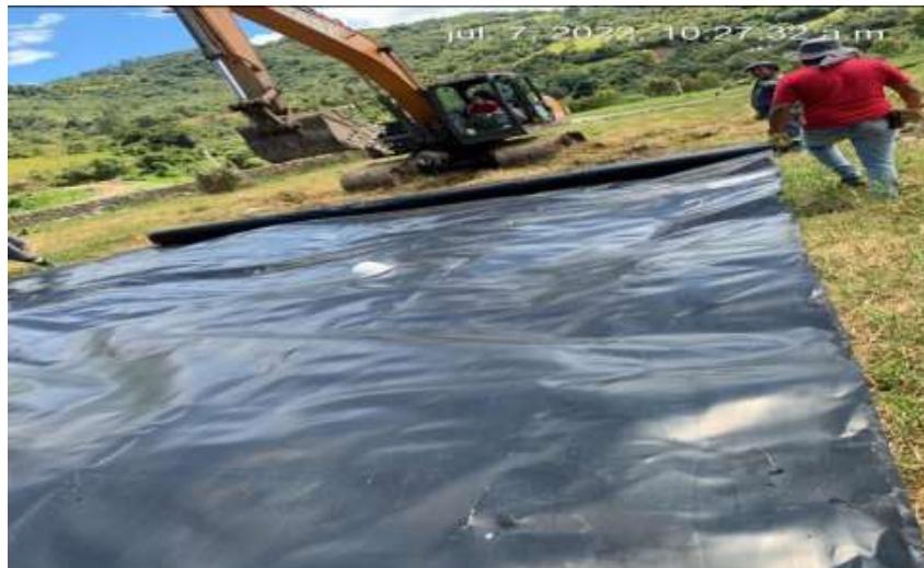
Figura 17. Extensión y evolución de las condiciones de la geomembrana
