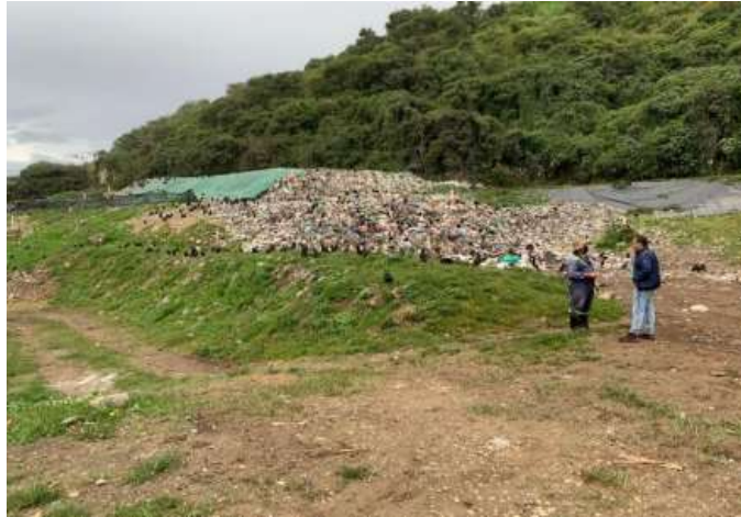
Figura 5. Reconocimiento del estado actual del relleno sanitario
