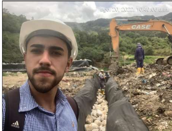
Figura 15. Supervisión de los frentes de trabajo en la construcción del filtro drenante.
