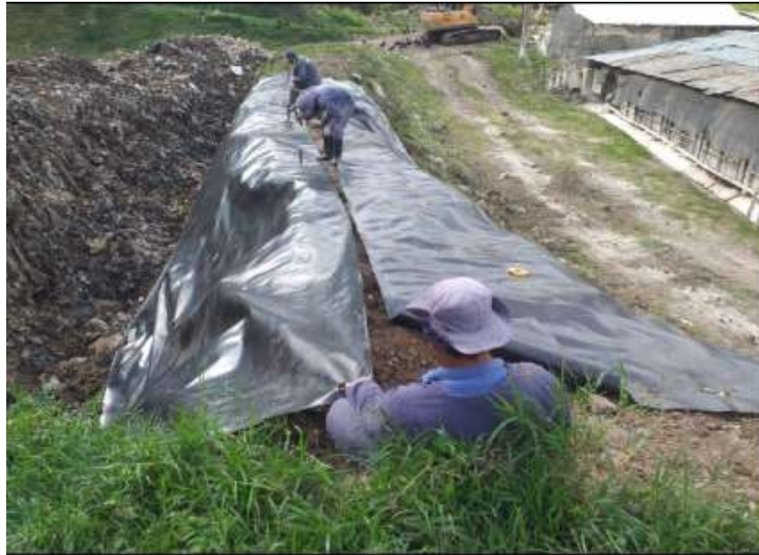
Figura 16. Instalación de geomembrana
