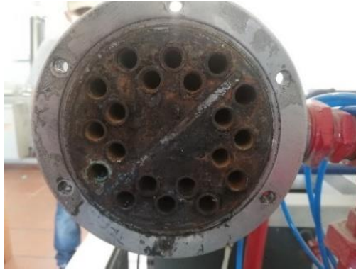
Figura 56. Limpieza y secado de los tubos en el extremo visibles del intercambiador de calor.
