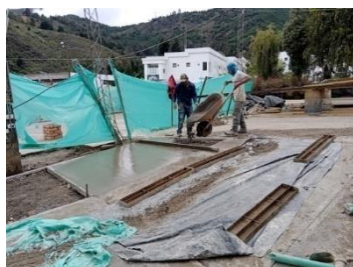
Ilustración 24 Transporte de mezcla
