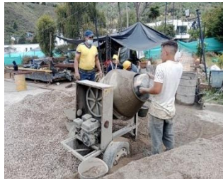
Ilustración 25 Agregado de cemento
