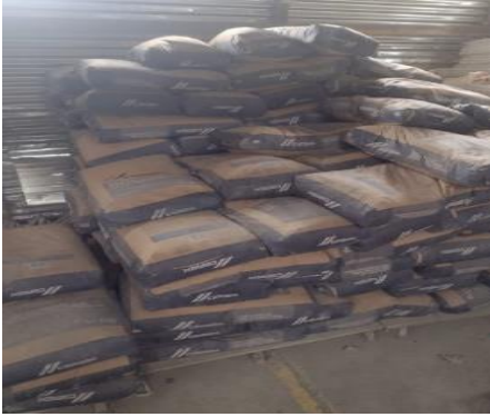
Ilustración 15 Almacenamiento de bultos de cemento
