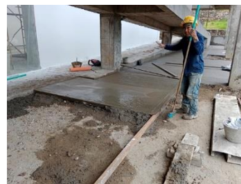
Ilustración 22 Aplicación de mezcla in situ
