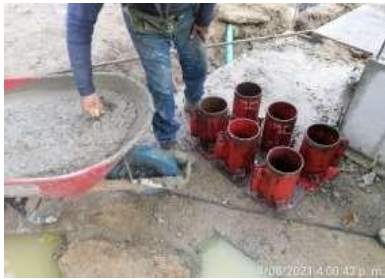
Ilustración 20 Vaciado de concretos en cilindros
