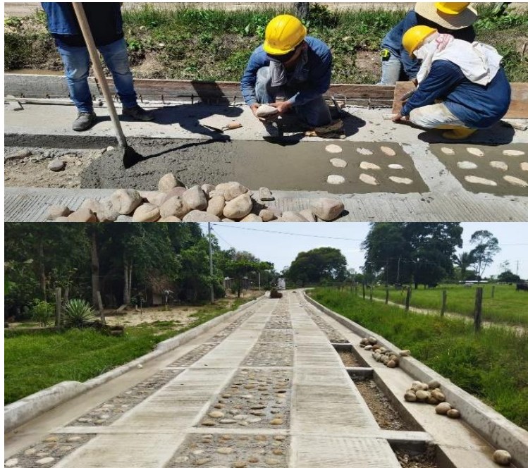
Figura 11: Colocación Piedra Pegada Concreto Clase D
