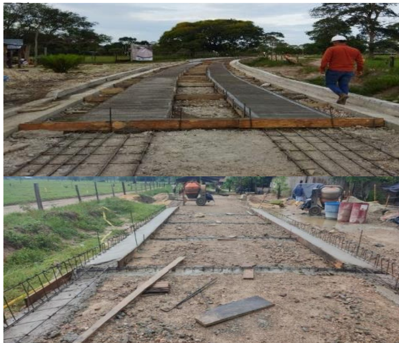
Figura 10: Colocación de solado concreto de 14 MPA Tipo
