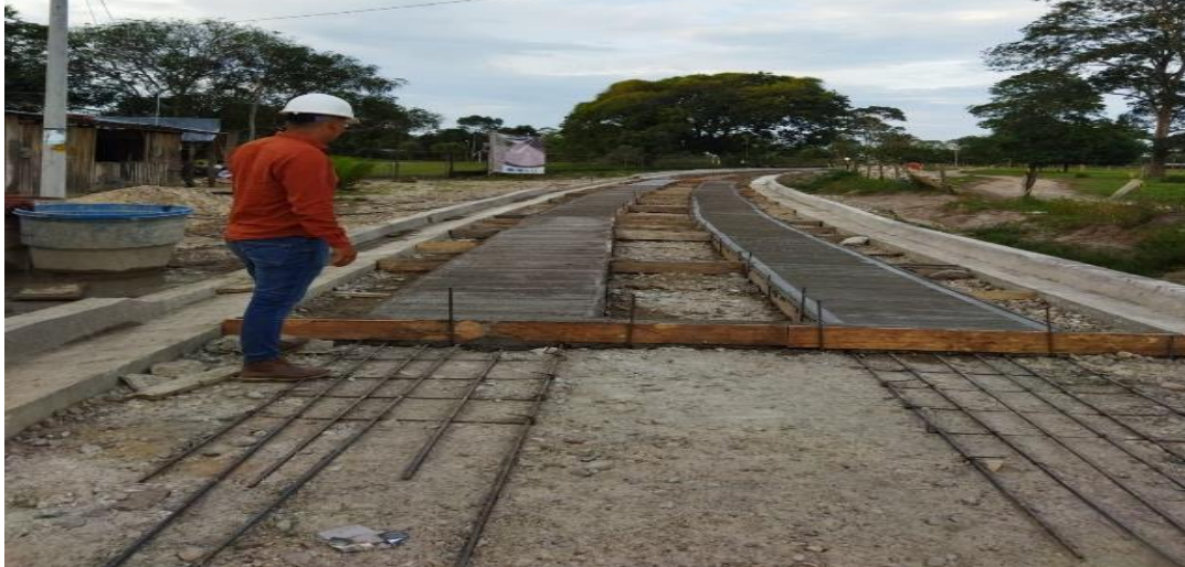
Figura 40: Curado del concreto con hidratación
