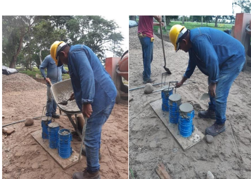
Figura 41: Llenado de concreto de cilindros
