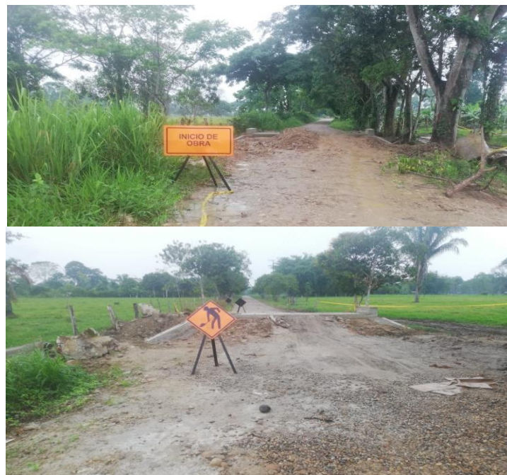
Figura 22: Señalización de la obra
