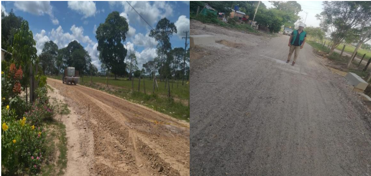
Figura 8: Aplicación de Subbase Granular
