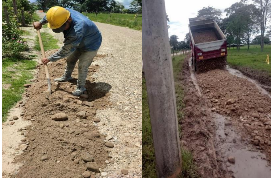
Figura 13: Relleno Para Estructuras con Recebo
