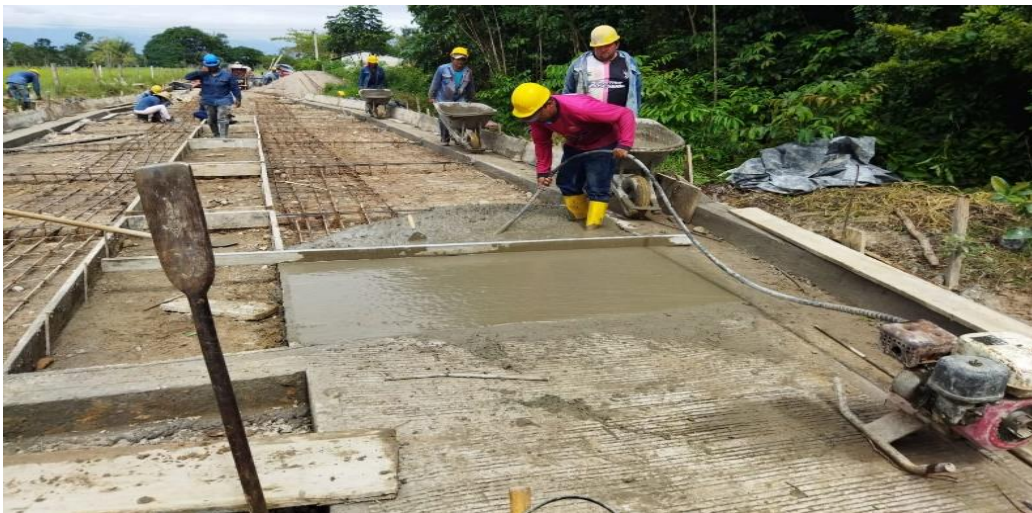
Figura 39: Vibrado del concreto
