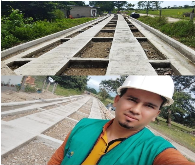
Figura 9: Concreto Para la Placa Huella de 21 MPA
