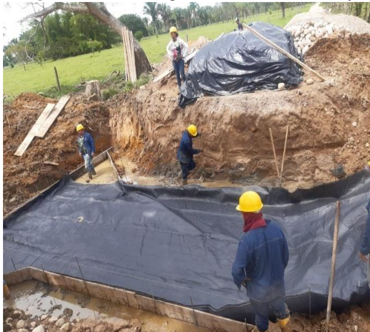
Figura 20: Geotextil tipo NT-2500 O similar no tejido
