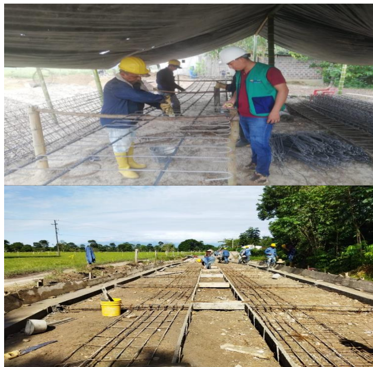
Figura 12: Figurado de acero de Fy 420 MPA
