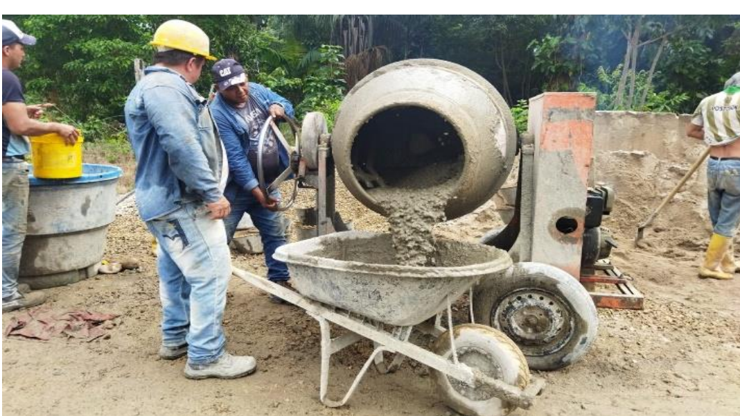
Figura 36: mezcla de concreto
