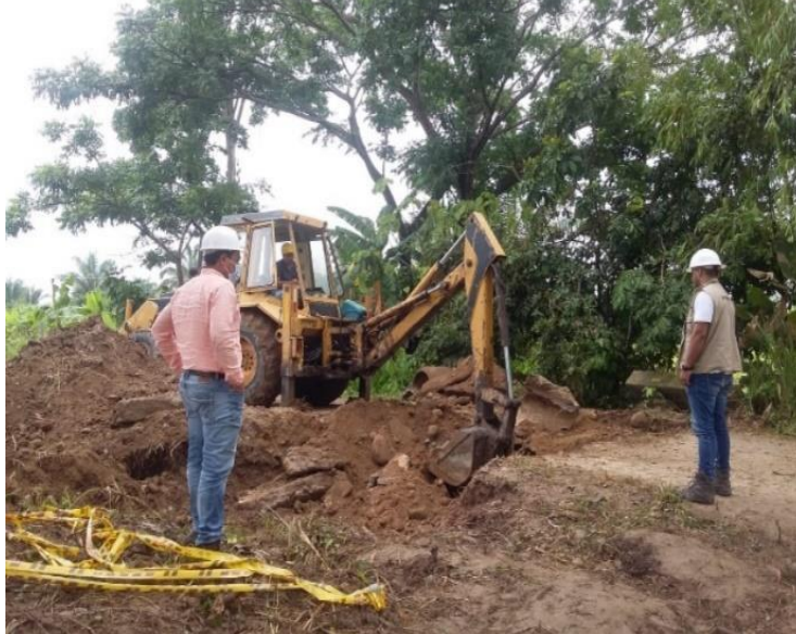
Figura 15: Actividades de demoliciones de estructura
