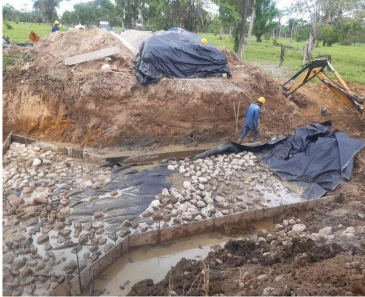
Figura 19: Material granular drenante
