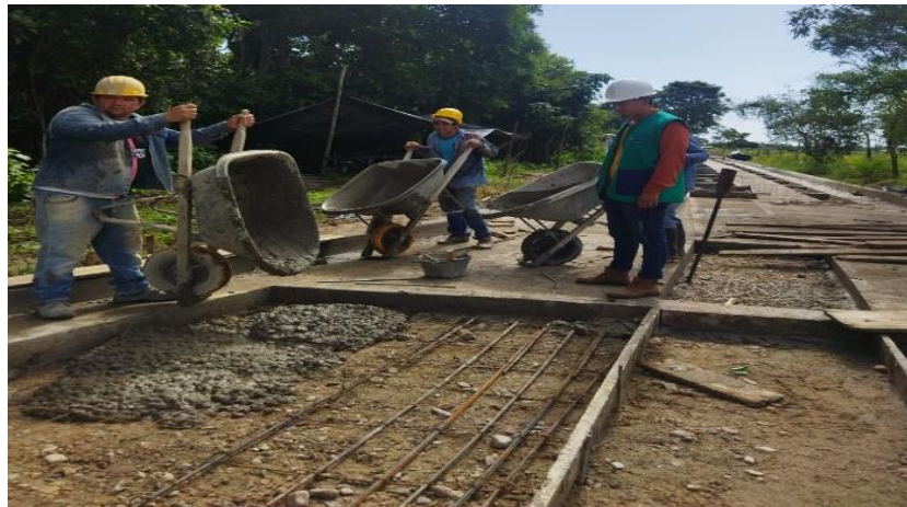
Figura 38: Vaciado en obra
