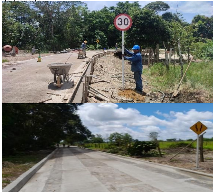
Figura 21: Suministro e instalación de señal vertical
