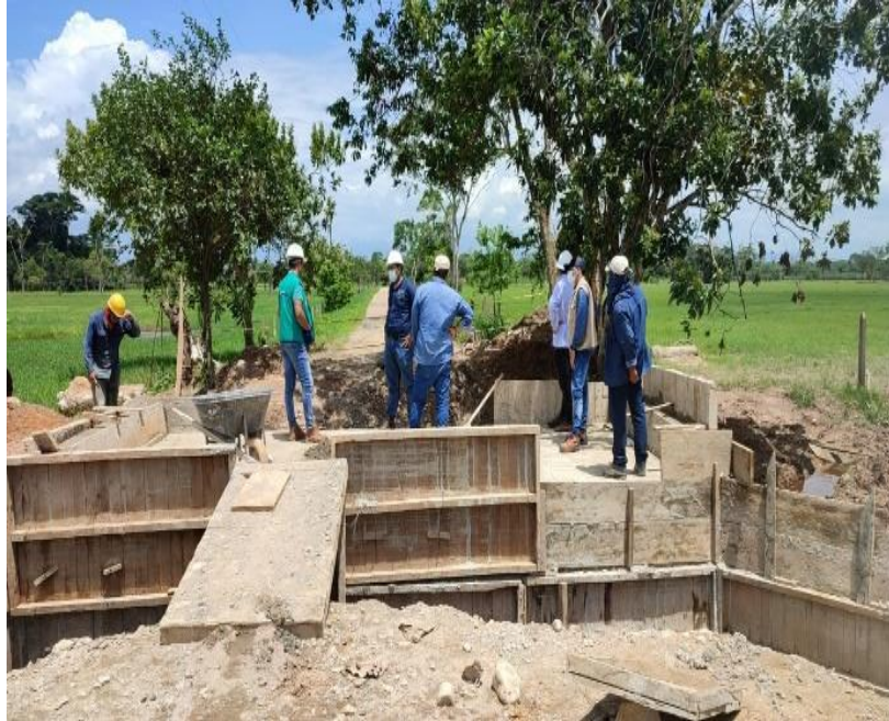
Figura 17: Concreto de resistencia de 21 MPA clase D
