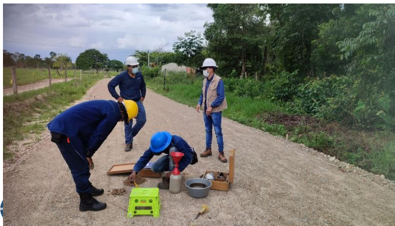
Figura 42: Ensayos in situ
