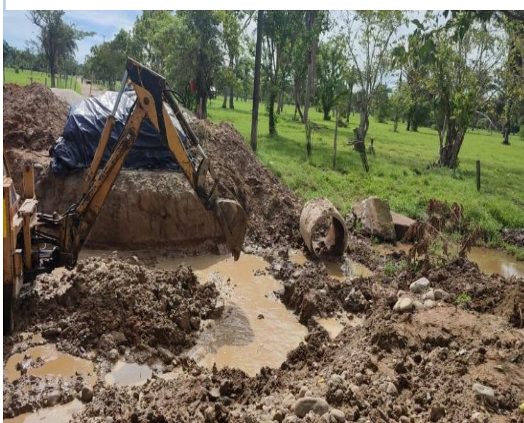
Figura 16: Excavación para box-culvert
