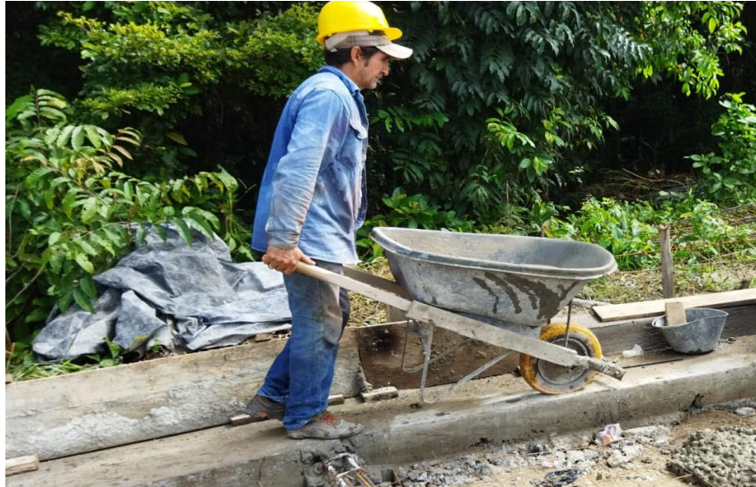
Figura 37: Transporte de concreto
