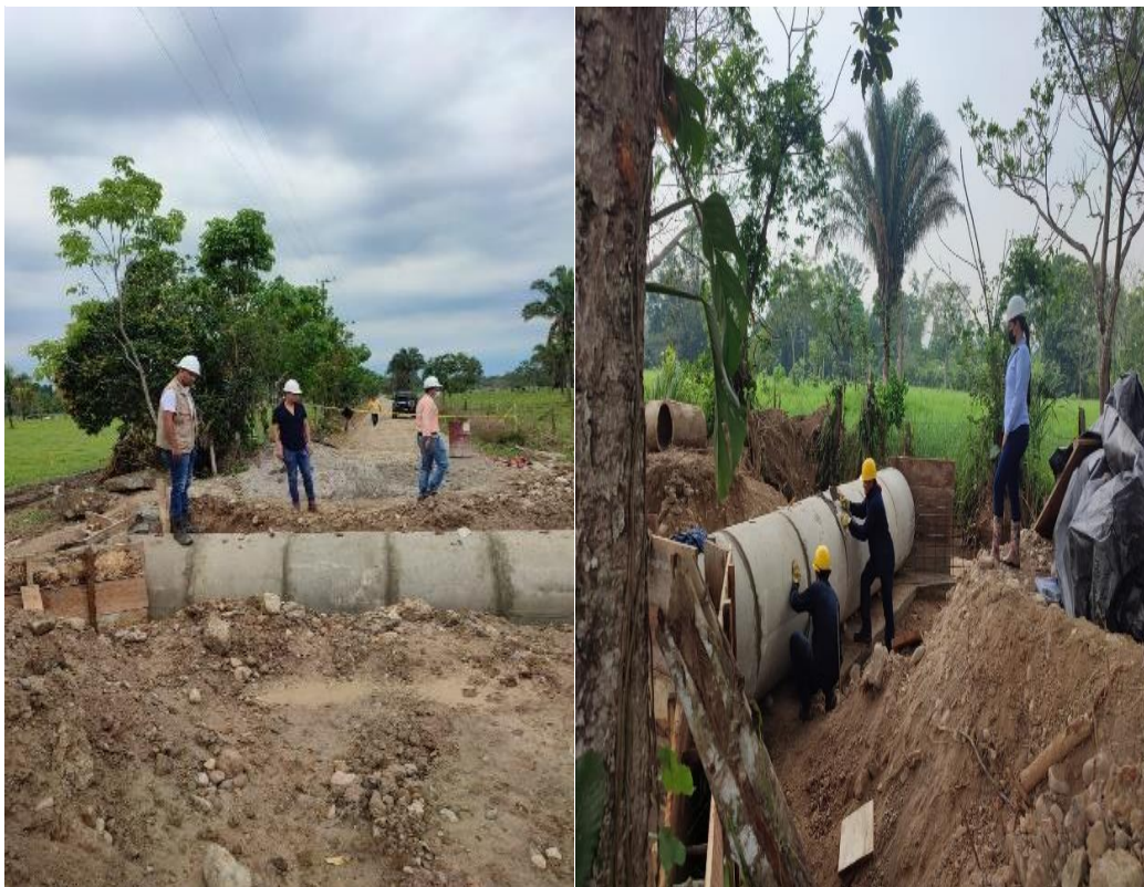
Figura 14: Colocación de tubería de concreto reforzado de 21 MPA 900 mm
