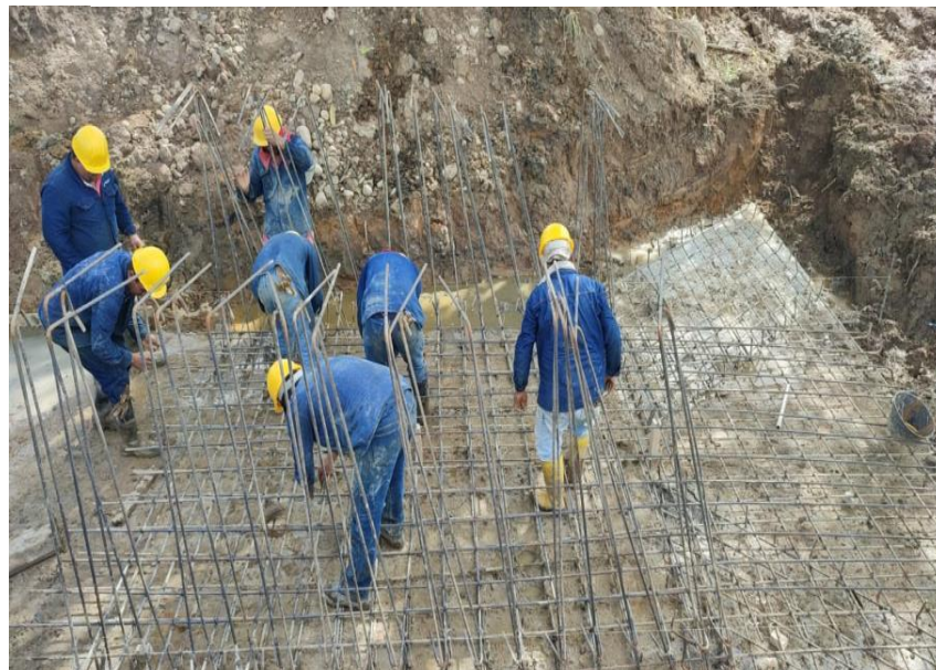
Figura 18: Acero de refuerzo fy 420 MPA
