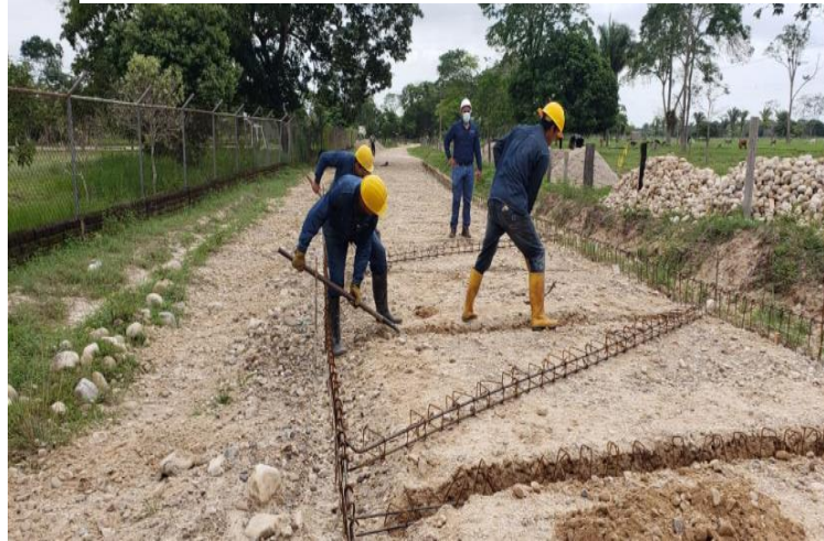
Figura 7: Excavación Varia sin Clasificar
