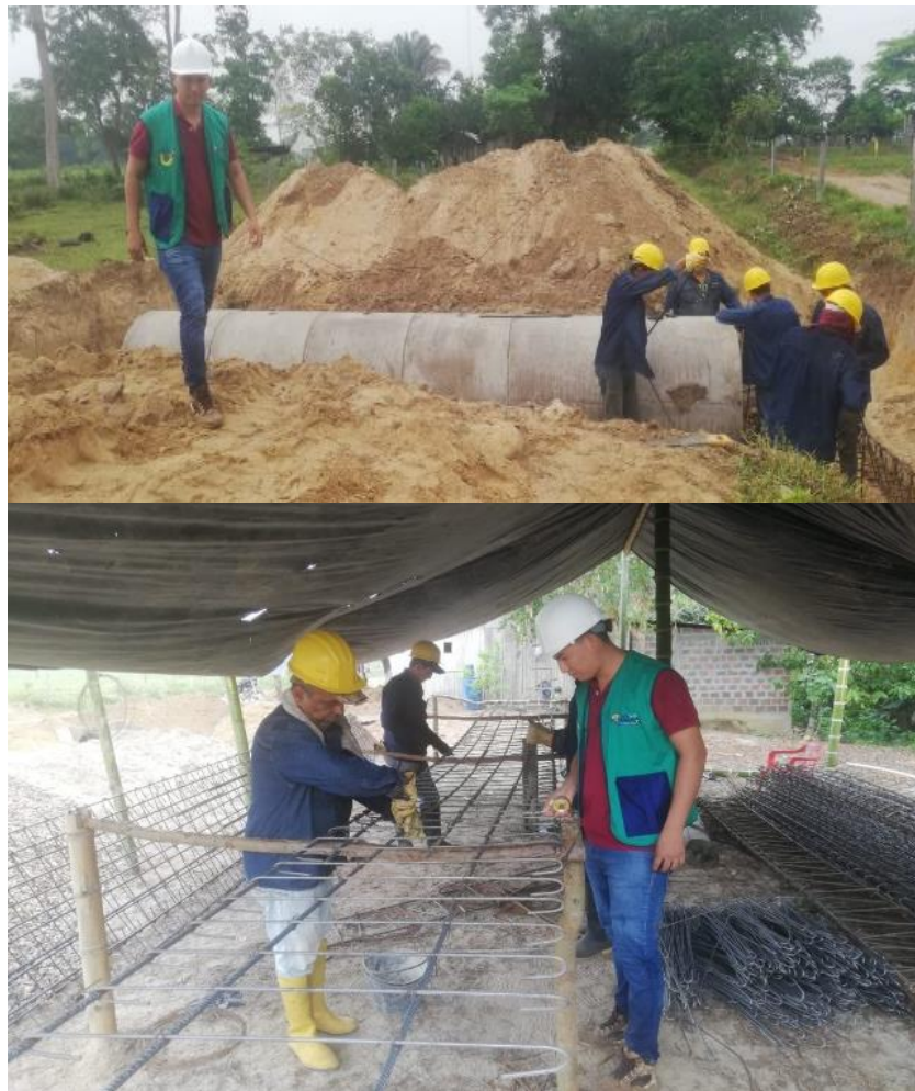
Figura 30: Uso correcto de elementos de protección personal
