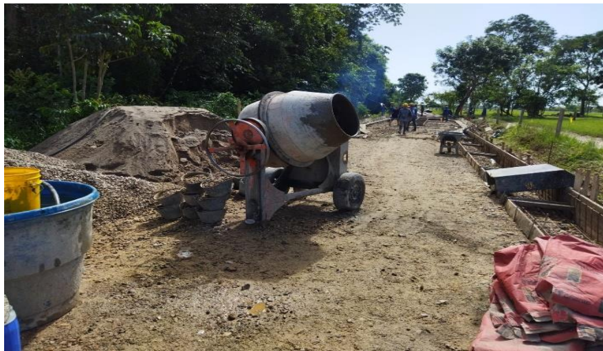
Figura 33: Preparación del equipo y lugar de colocación
