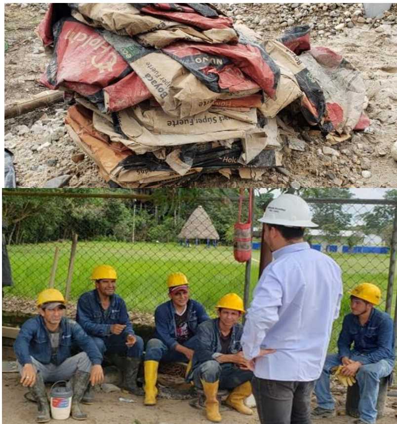
Figura 31: Limpieza del sitio de trabajo
