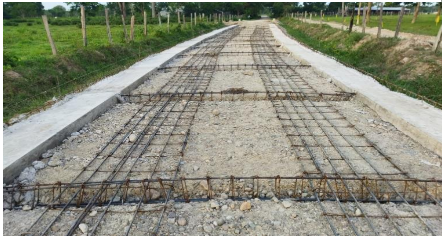
Figura 34: Vaciado del concreto
