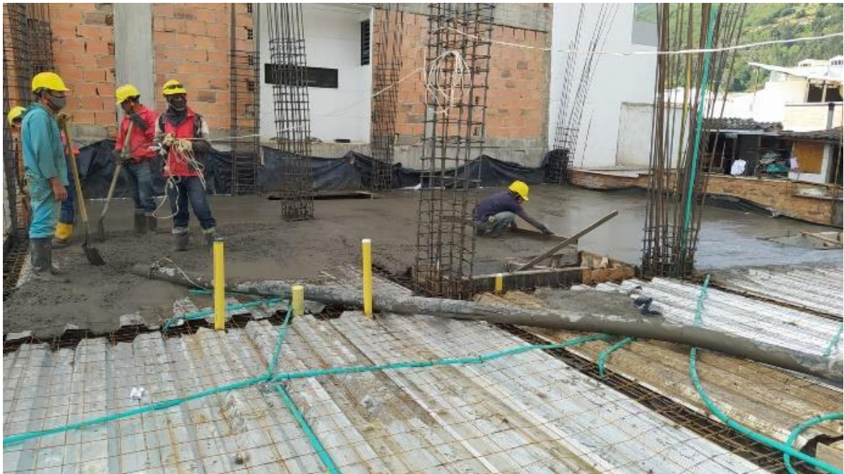
Figura 13. Fundación de la placa entrepiso
