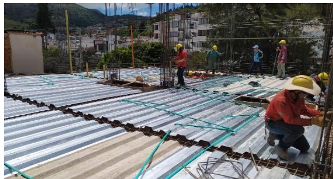
Figura 16. Instalación de puntos hidráulicos y eléctricos
