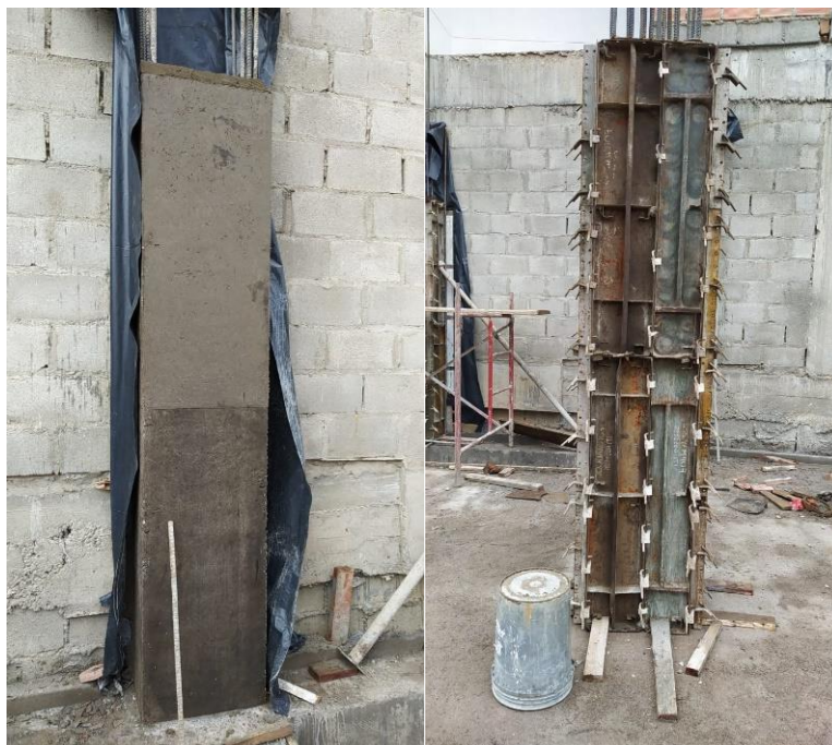
Figura 12. Fundación de concretos
