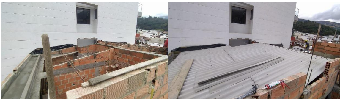
Figura 18. Instalación de cubiertas en la obra
