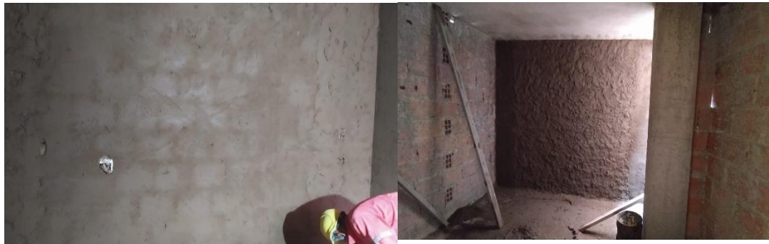
Figura 17. Revoque de muros en la obra
