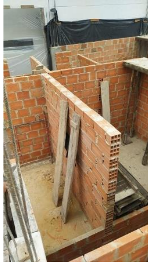
Figura 15. Construcción de muros en la obra
