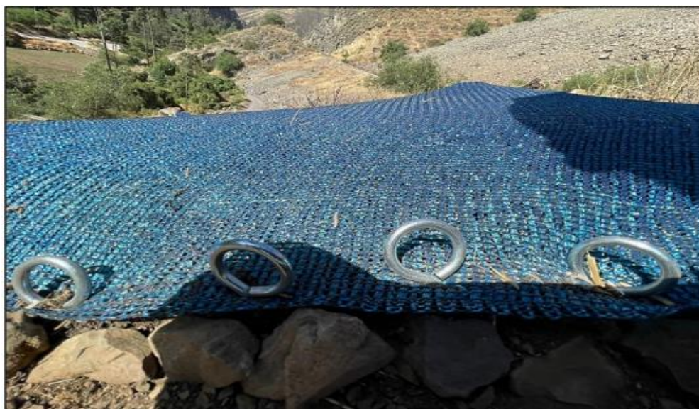
Ilustración 20: Anclajes de geomalla (Arauzo, 2020)
