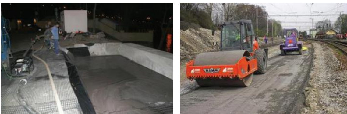
Ilustración 6: Disposición y compactación de ceniza estabilizada en aplicación húmeda. Republica Checa, 2016 (Vaniček, Jiráskoa, & Vaničekb, 2017).
