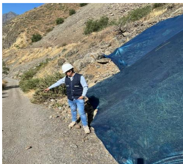
Ilustración 21: Contención de rocas por la geomalla (Arauzo, 2020)
