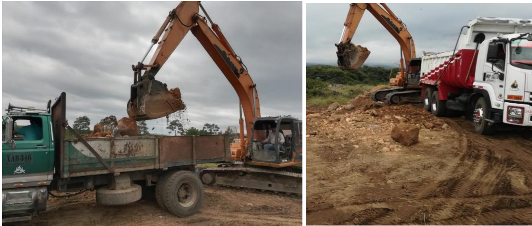
Ilustración 28 Excavación mecánica en material común
