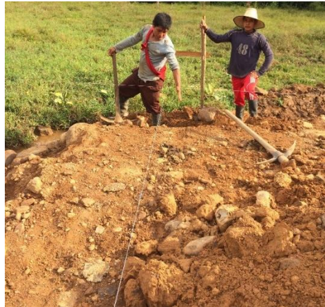
Ilustración 35 Excavación manual en material común
