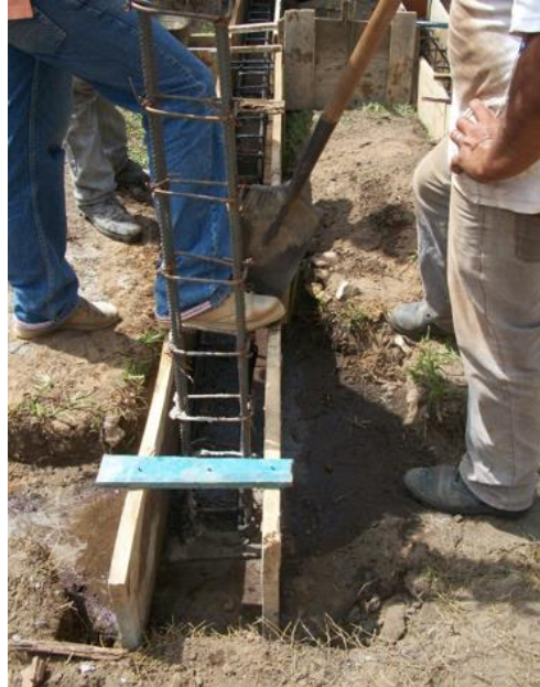
Ilustración 31 Concreto de limpieza 10,5 MPa
