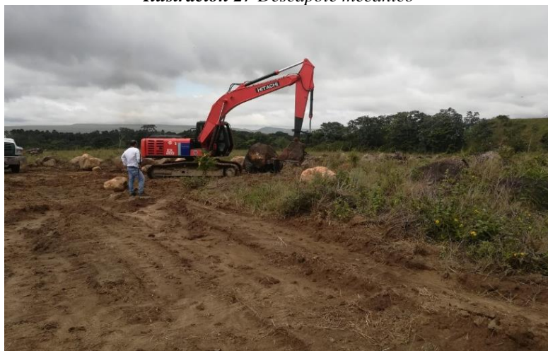
Ilustración 27 Descapote mecánico
