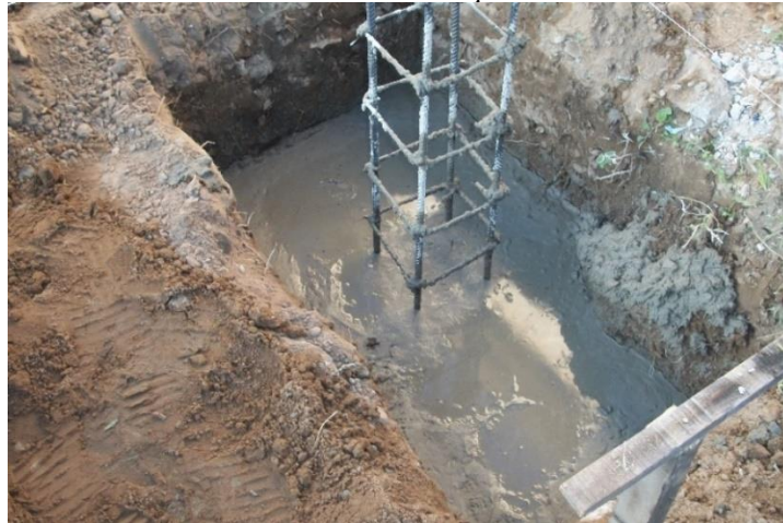
Ilustración 32 Concreto zapatas 21 MPa
