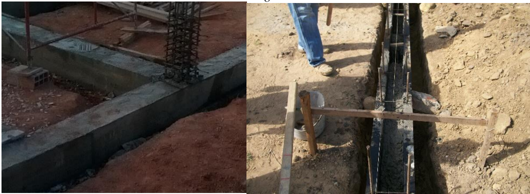
Ilustración 33 Concreto vigas de cimentación 21 MPa
