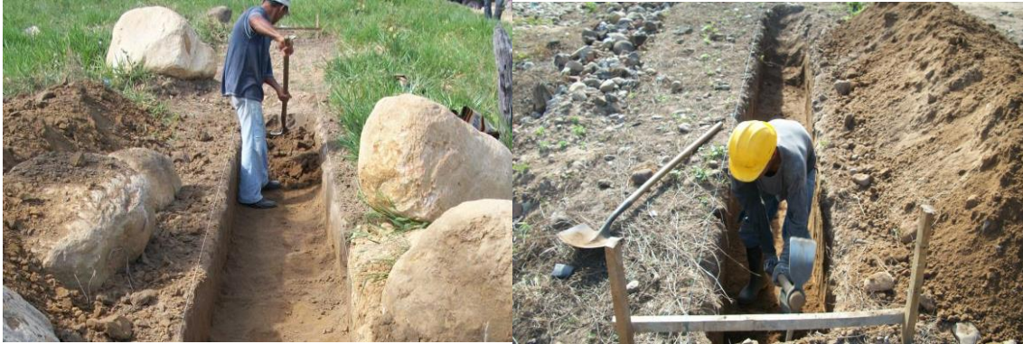
Ilustración 29 Excavación manual en material común
