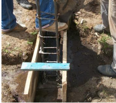
Ilustración 34 Acero de 60000 Psi
