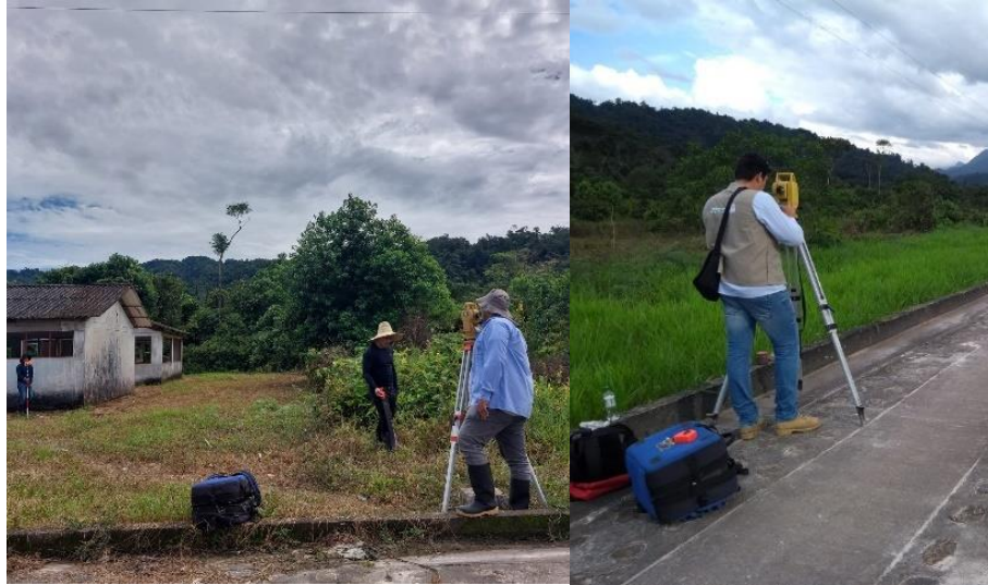
Ilustración 26 Localización y replanteo
